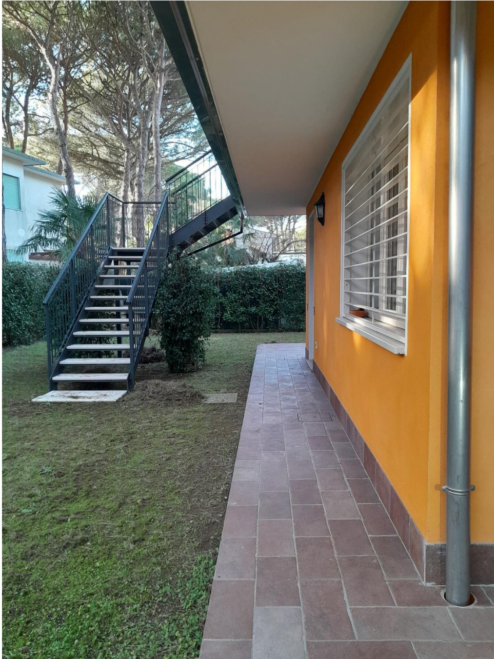
FOTO N.07_Zona scoperto esclusivo (parte pavimentata)
