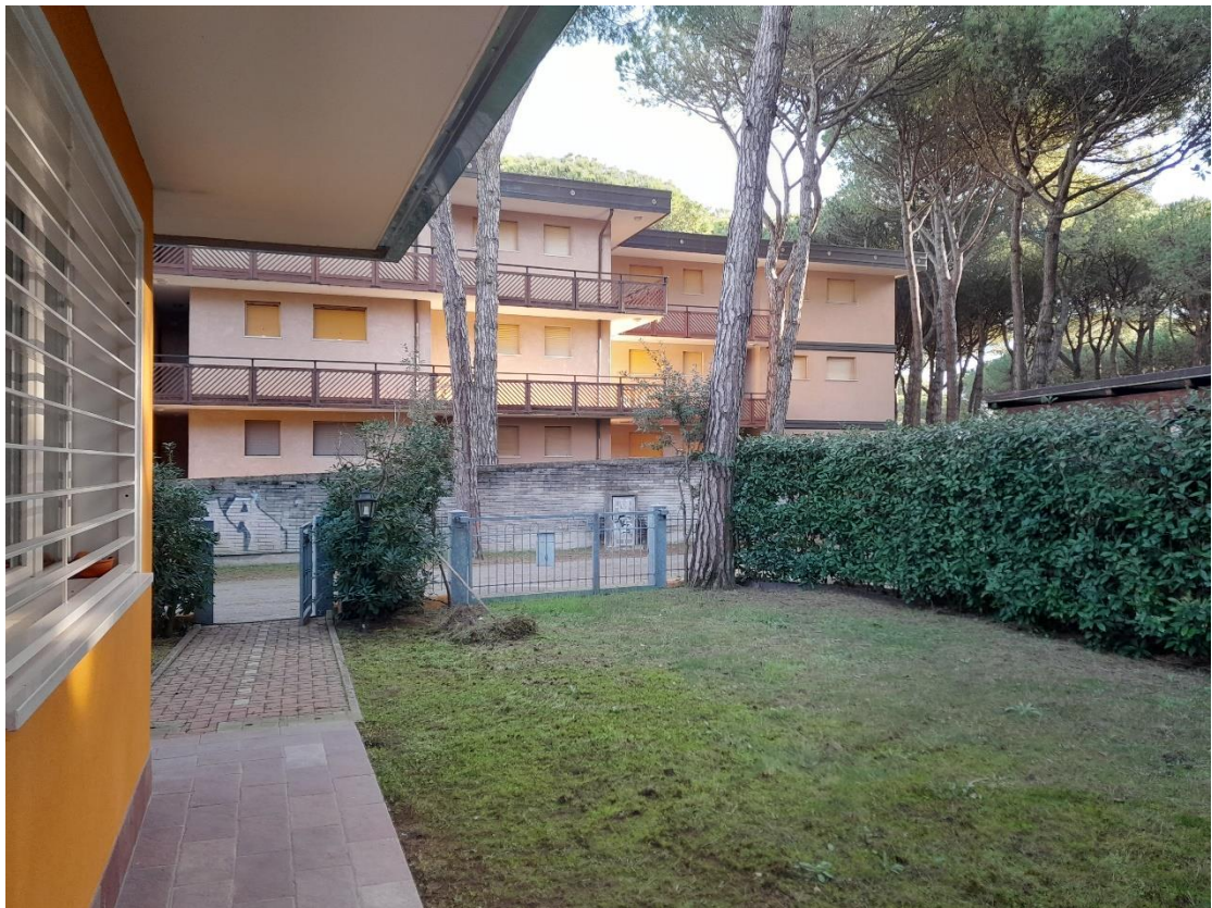
FOTO N.05_Zona accesso carraio
