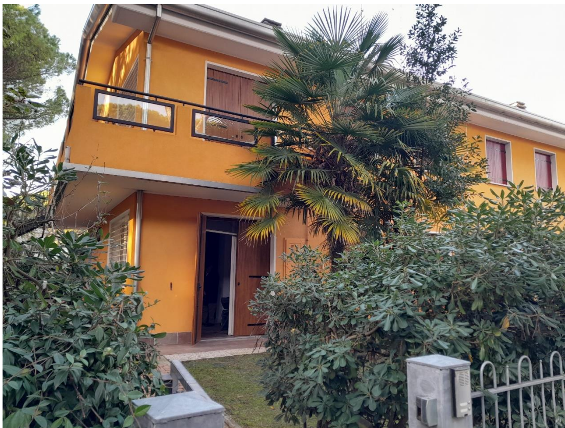
FOTO N.02_ Prospetto Est (ingresso)
