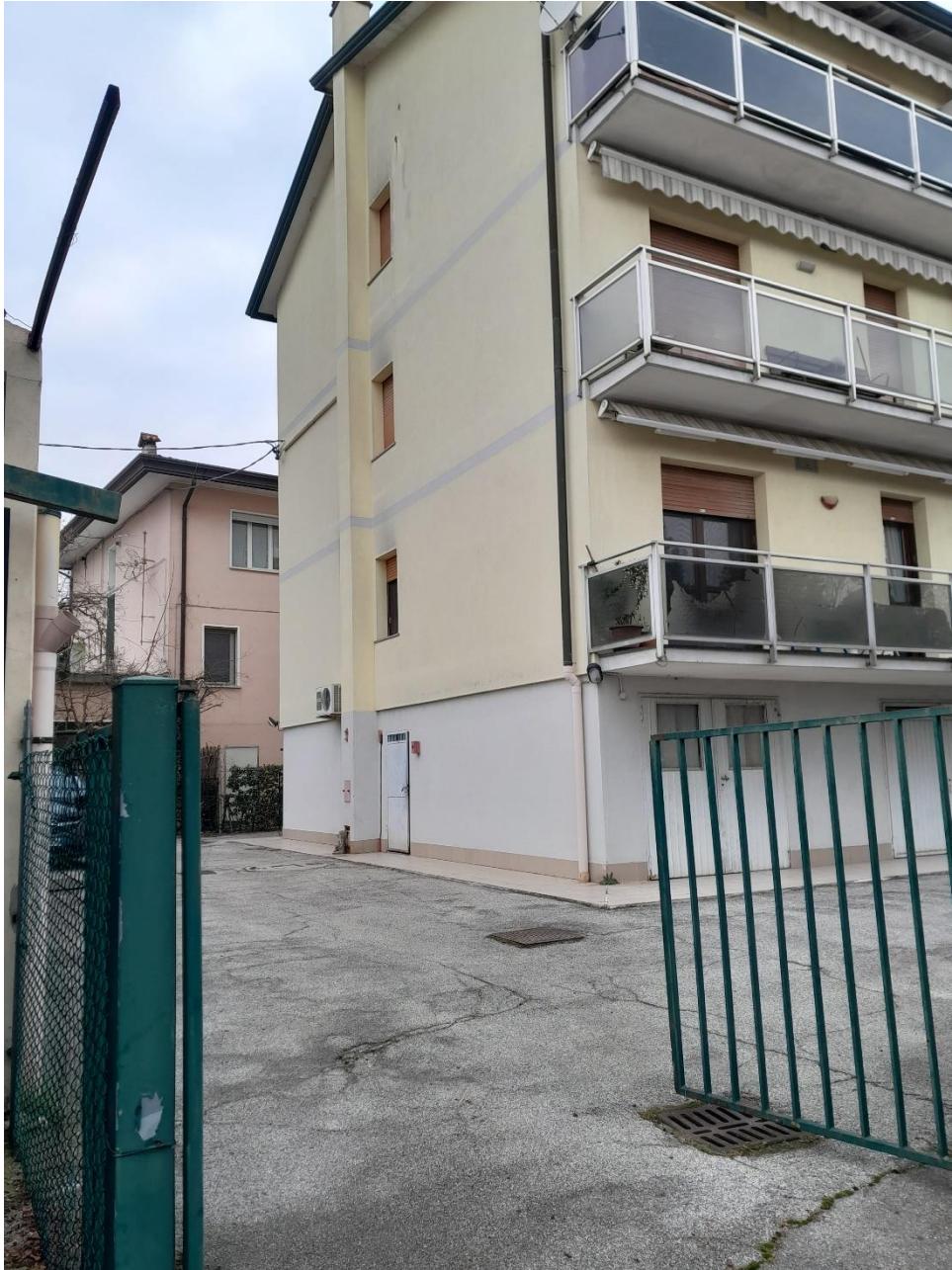
Foto 03 – Prospetto Sud-Est– Accesso carraio da strada privata
