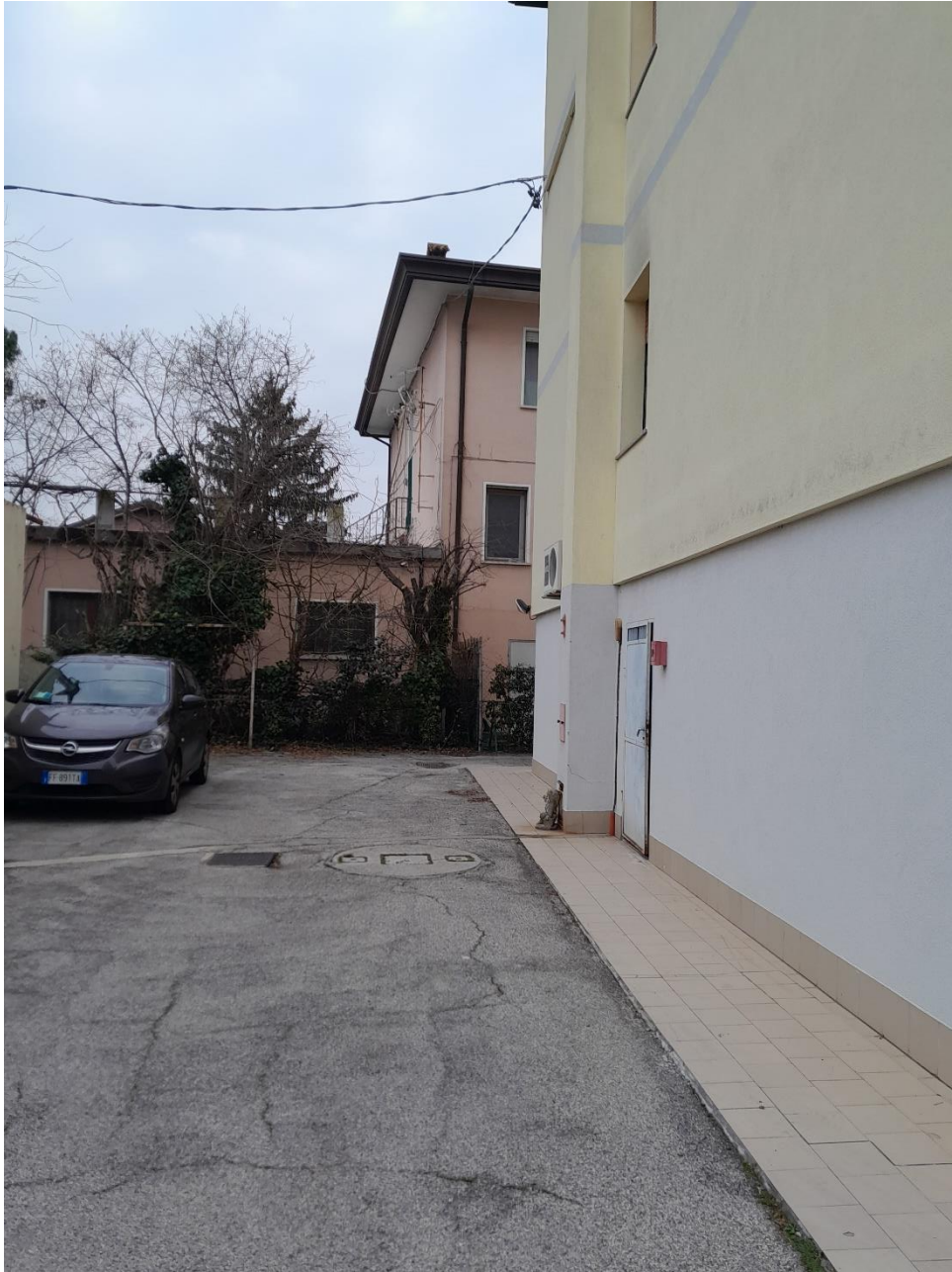
Foto 05 – Prospetto Sud – accesso CT
