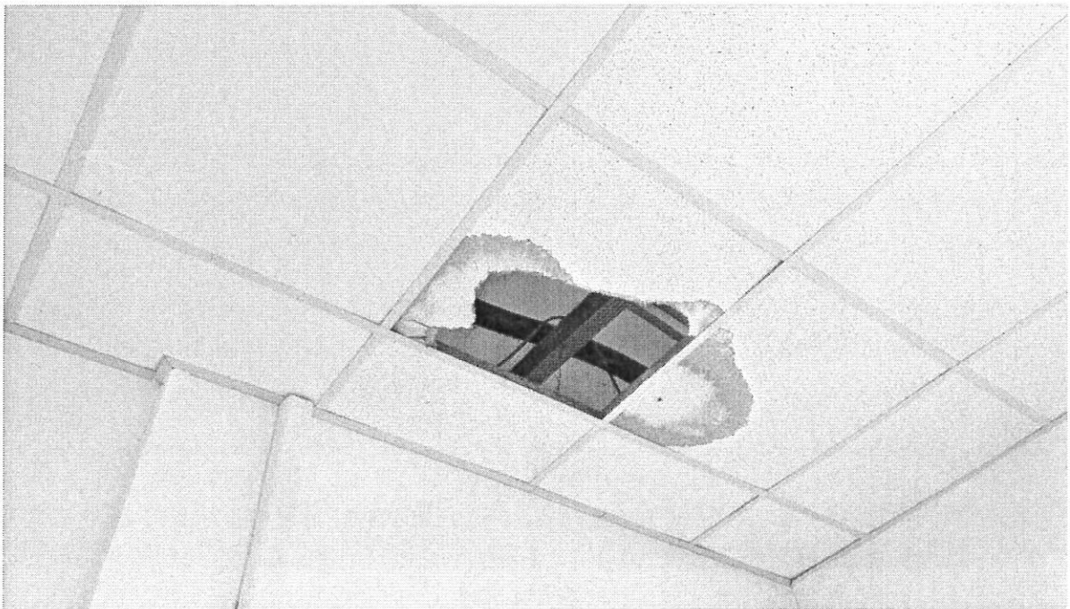
Figura 17. Uffici. Particolare del soffitto.
