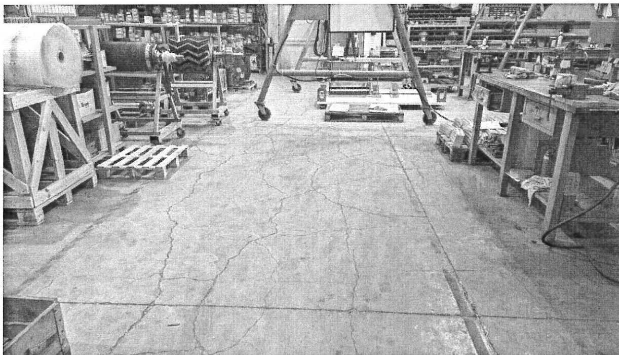
Figura 24. Opificio, interni. Particolare della pavimentazione.
