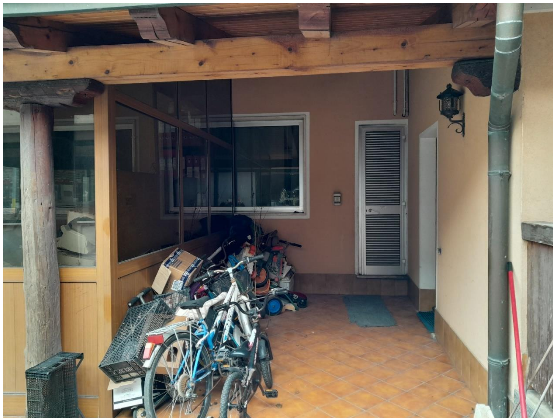
FOTO N.26_ Prospetto Sud- Ingresso CT ufficio
