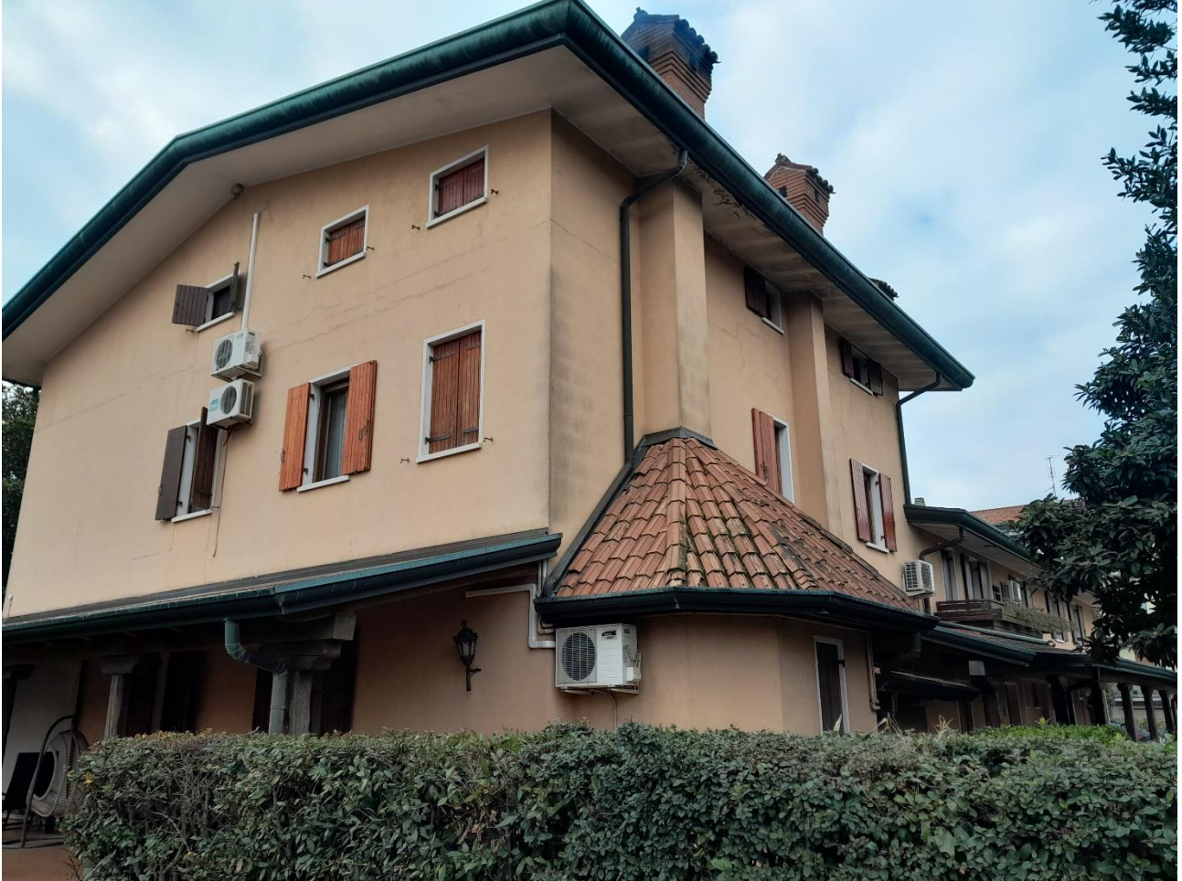
FOTO N.02_ Prospetto Nord-Est abitazione cat. A/7
