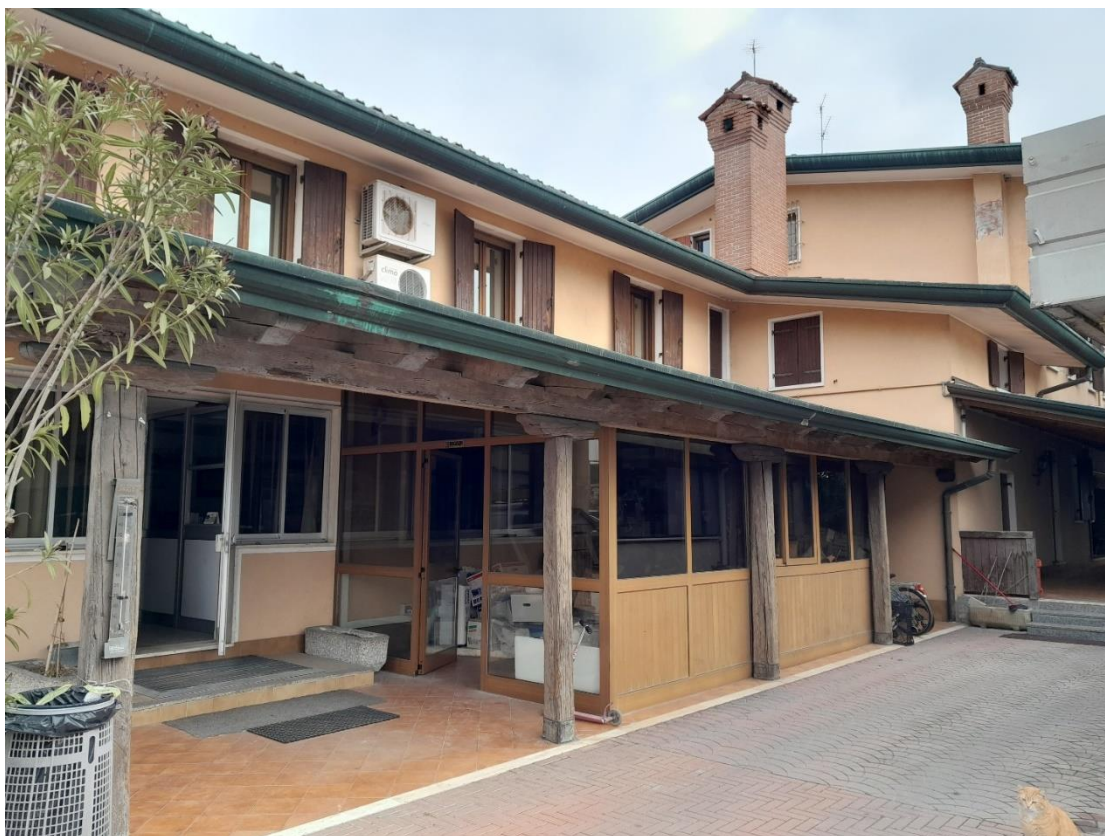
FOTO N.25_ Prospetto Sud- Ingresso ufficio locali al pinao terra
