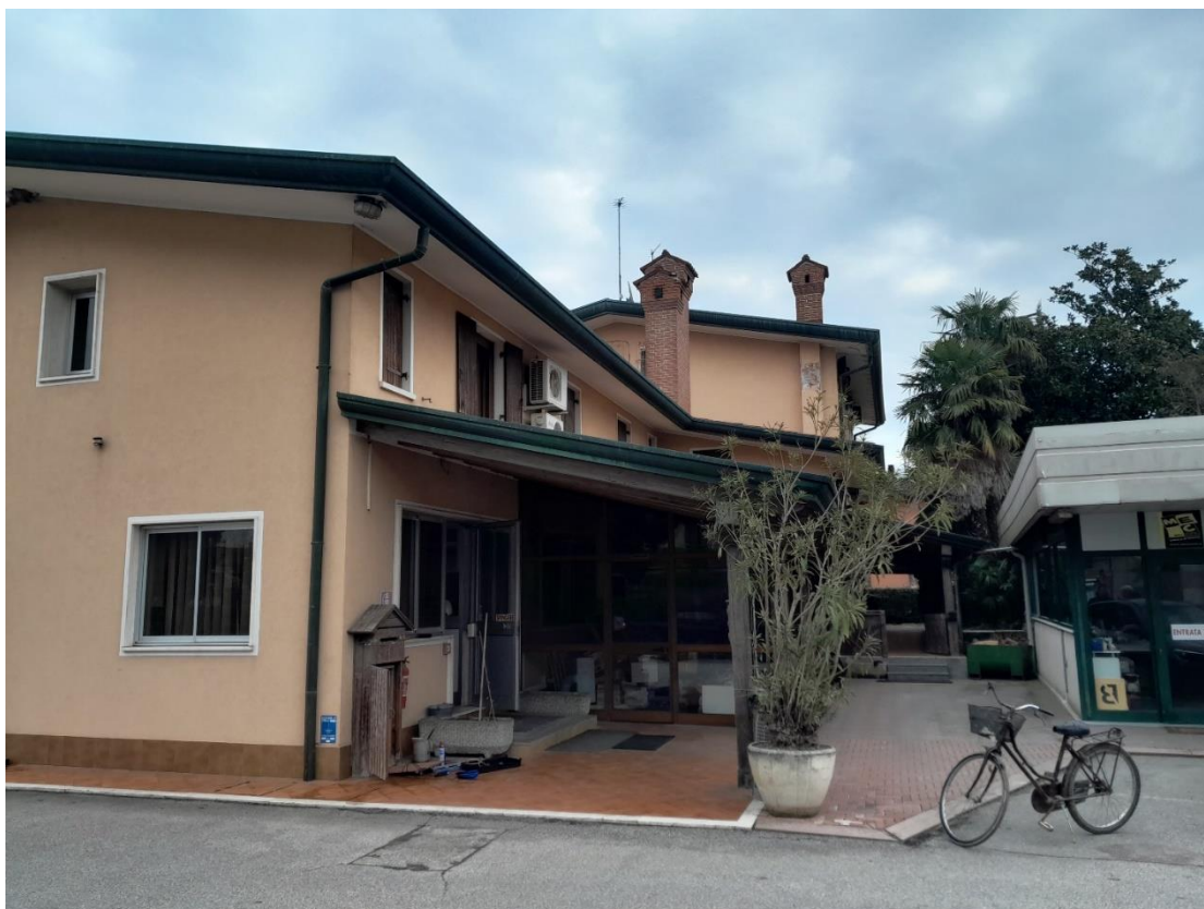
FOTO N.23_ Prospetto Ovest – Ingresso ufficio
