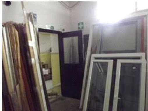
Vista accesso del locale spogliatoio
