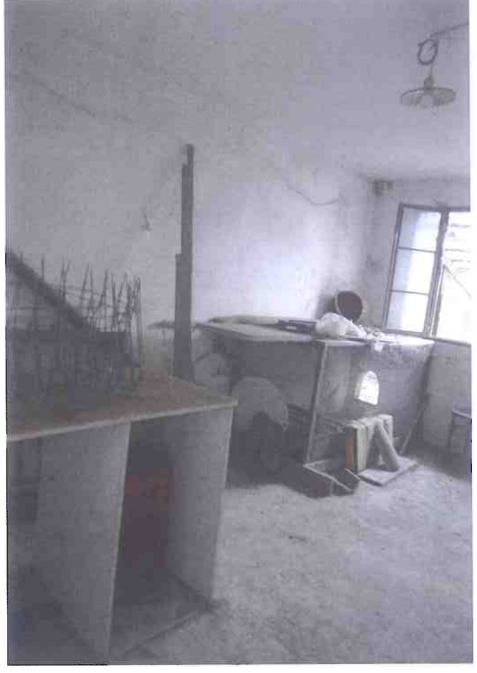
Foto 004 - Locale 2 Interrato piano secondo.JPG
