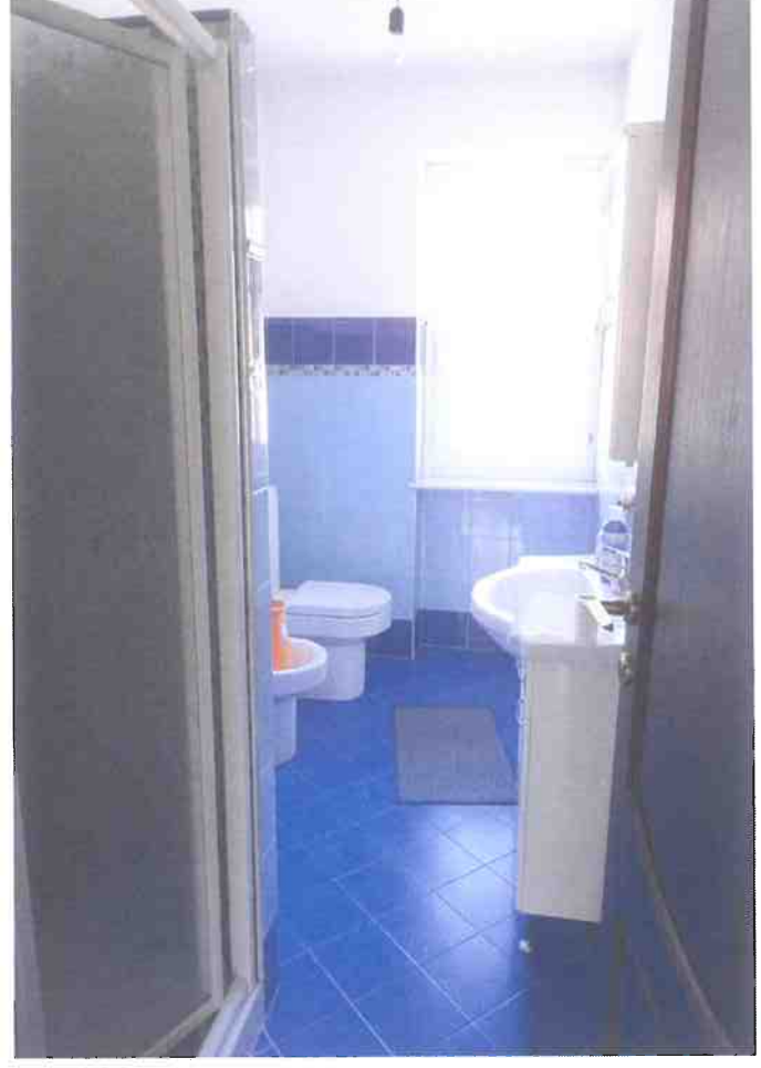
Foto 020 - P. Secondo - Bagno.JPG
