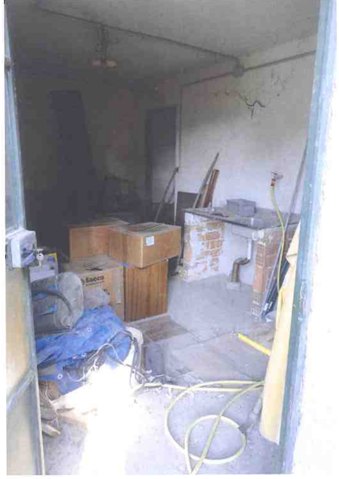
Foto 003 - Locale 1 Interrato piano secondo.JPG
