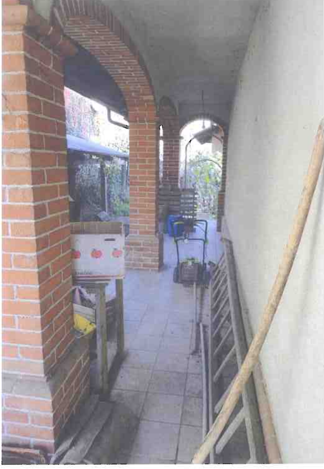
Foto 022 - P. Secondo - Porticato lato Ovest 2.JPG
