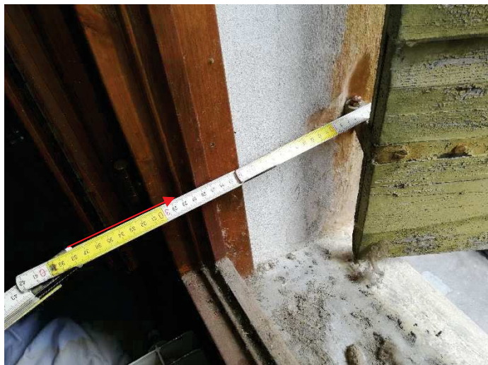
Foto 23. Particolare muri perimetrali
