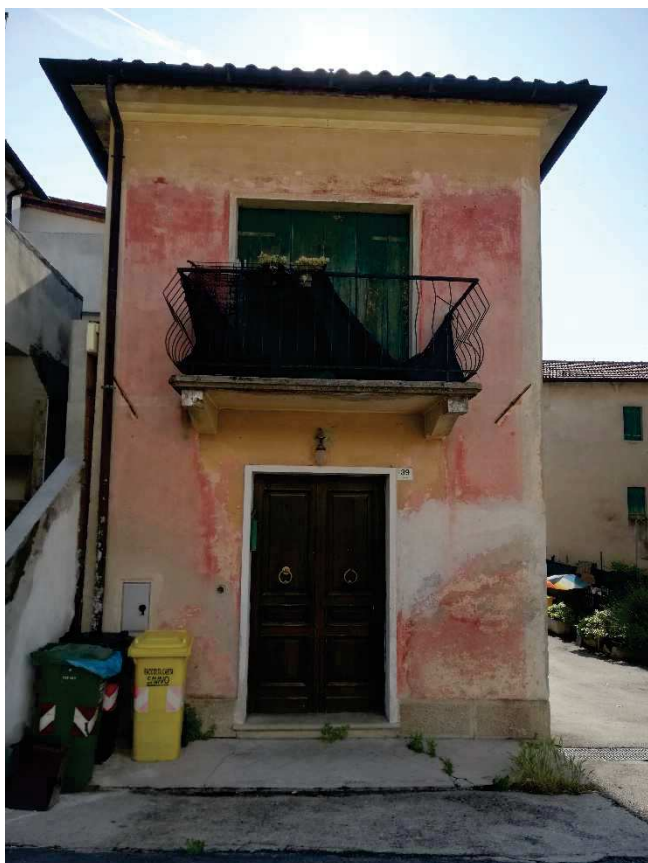
Foto 1. Vista Prospetto Principale Ovest
