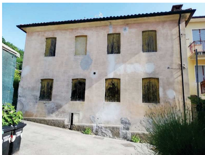
Foto 2. Vista Lato Sud
