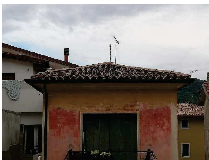
Foto 30. Vista copertura Ovest
