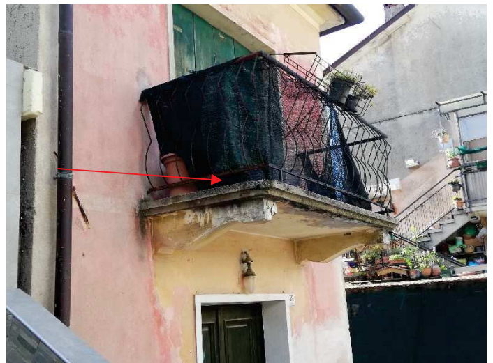
Foto 6. Vista Terrazzo sopra ingresso
