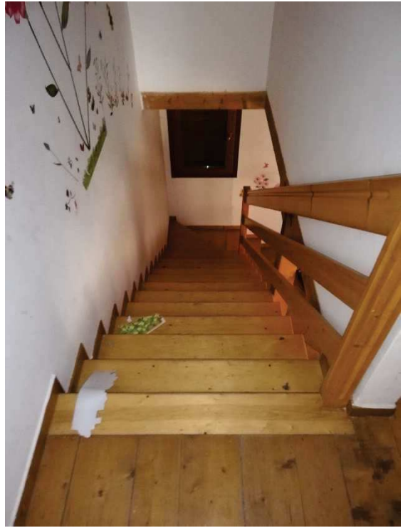
Foto 16. Vista scala dal piano primo
