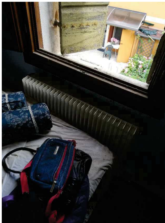
Foto 24. Vista muri e radiatori
