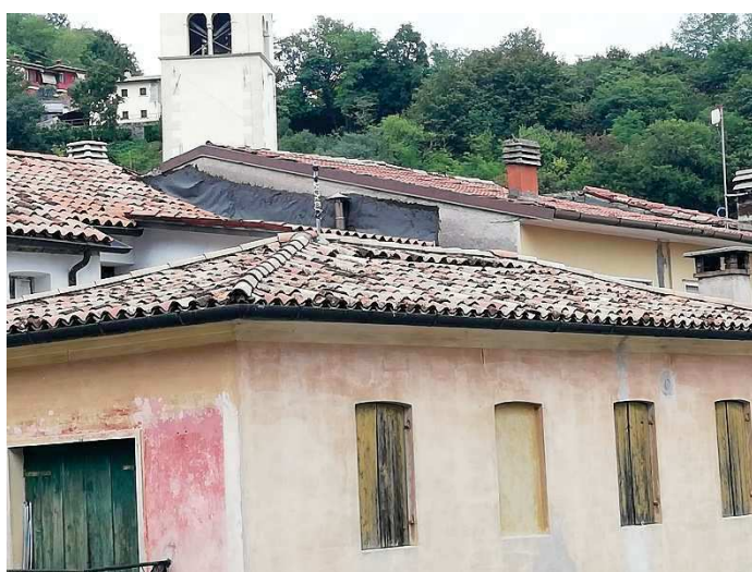
Foto 29. Vista copertura Sud - Ovest
