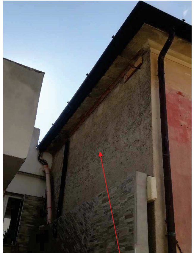
Foto 4. Vista Facciata Nord
