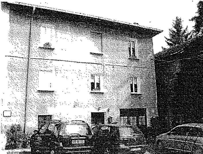
1 - Fronte su Via Trento, 46
