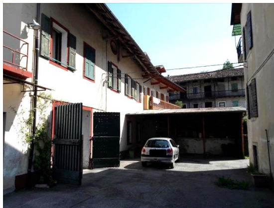
Part. 587 sub. 1 – Tettoia sud-est, corte e sul lato destro fabbricato part. 588
