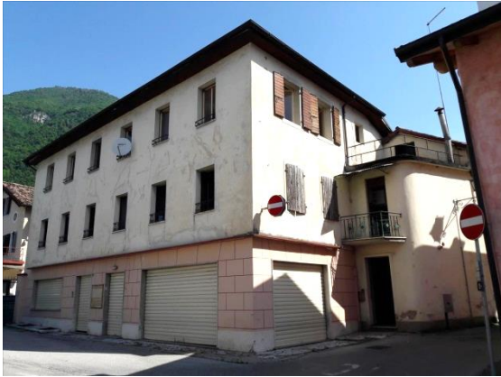
Part. 588 sub. 3 negozio al PT e sub. 4 appart. al P1, P2 – Sulla destra ingresso sub. 4 da via Molini 1
