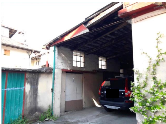
Part. 587 sub. 1 – Tettoia e ripostigli lato ovest
