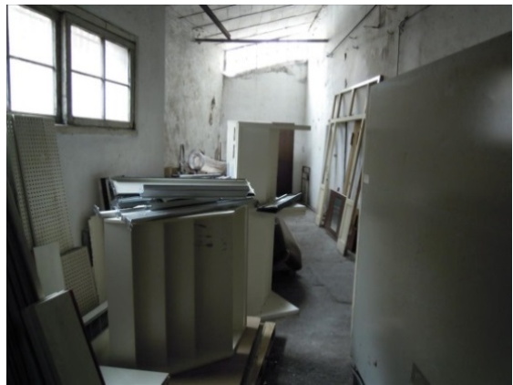
Part. 587 sub. 1 – Magazzini lato nord
