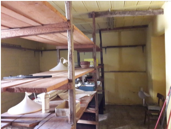
Part. 588 sub. 3 - Magazzino lato nord
