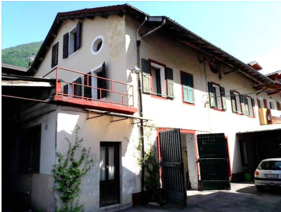
Part. 587 lato sud-est - PT sub. 1 e P2-P3 sub. 2
