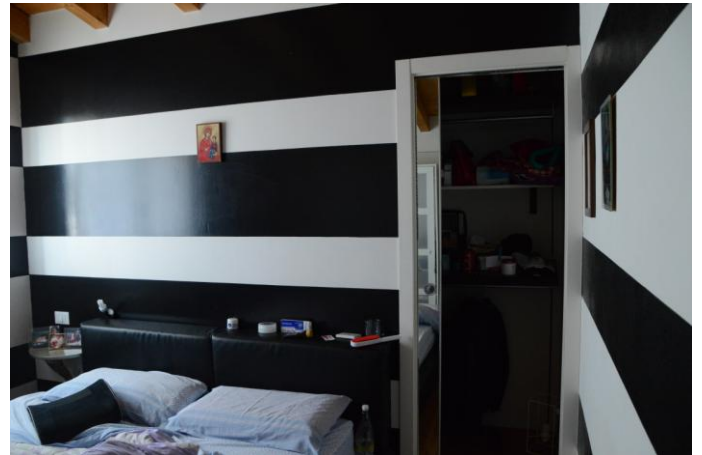
Foto 12 – Cabina armadio da demolire
