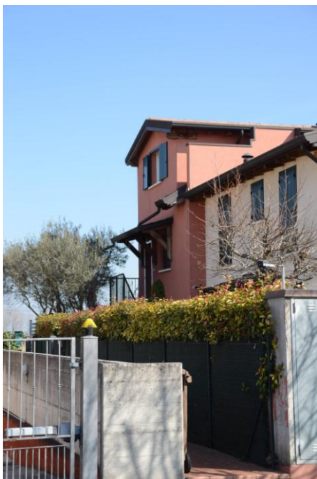
Foto 1 – Prospetto principale da ingresso pedonale
