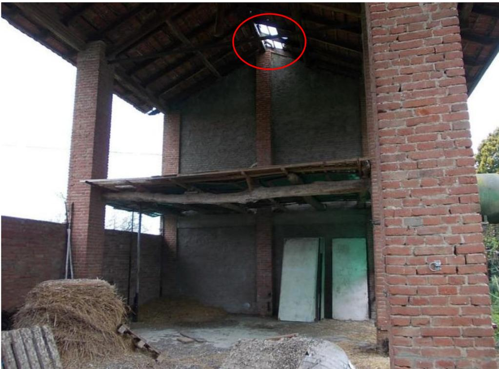
Foto 36 Tettoia con porzione di tetto crollato mapp.336 sub.4 p.t.
