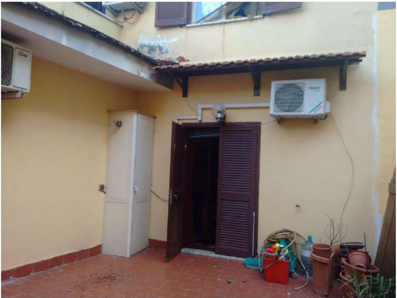
Foto 31– Terrazzo dell'appartamento ubicato al piano secondo int.3 (sub.108)
