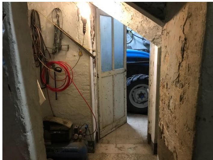
Rimessa nord del piano terra
