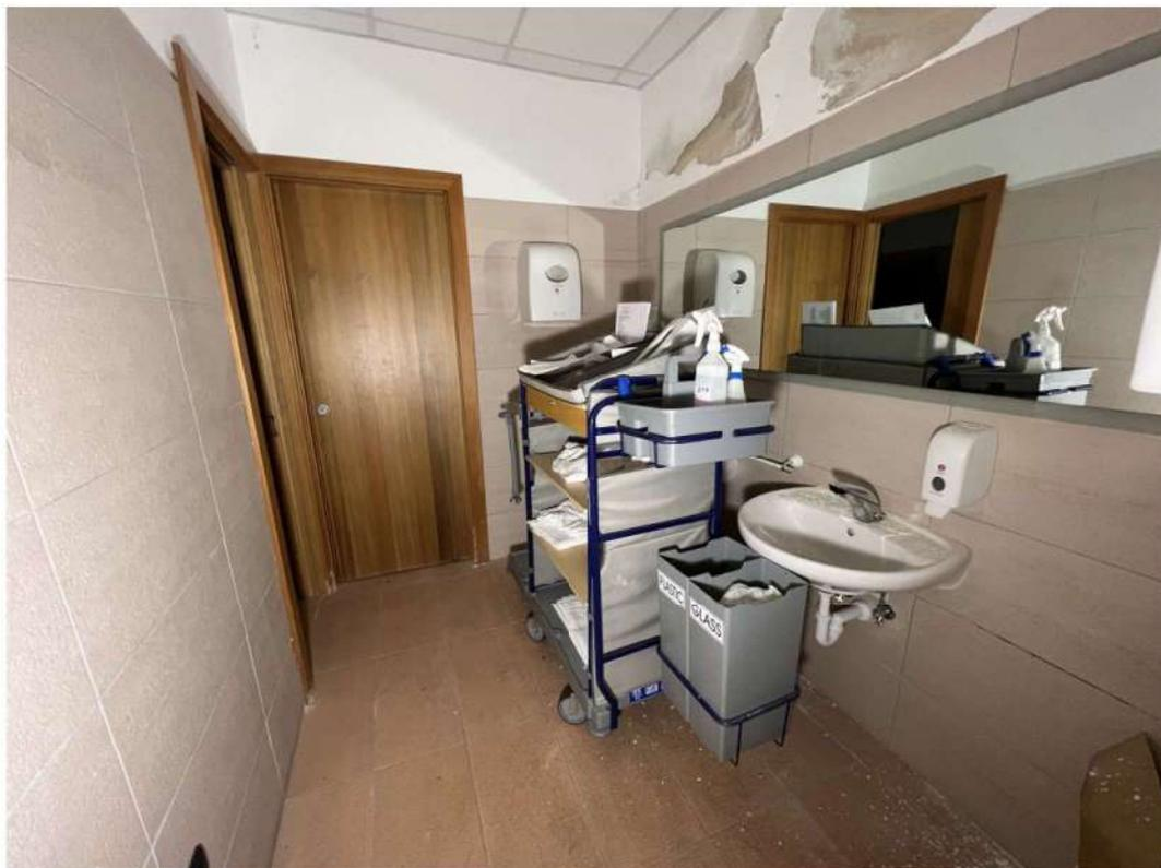
Piano seminterrato – Pareti e soffitti ammalorati
