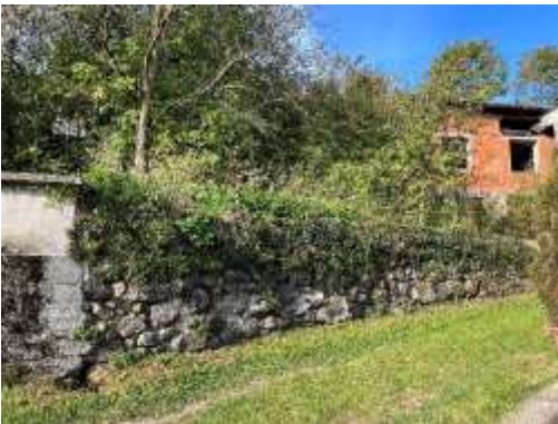
Esterno – accesso al fabbricato
