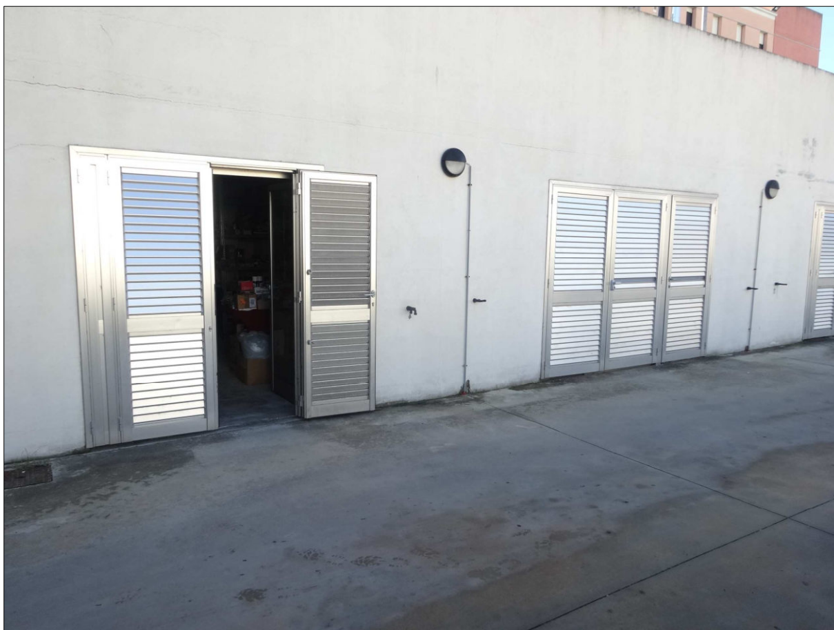
Foto 11 – ingresso principale del magazzino
