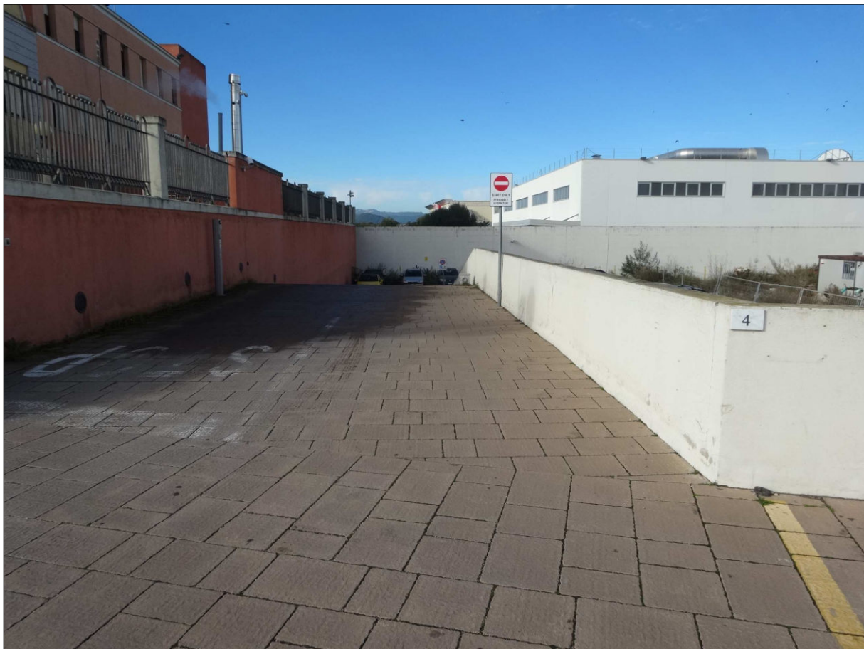
Foto 2 – rampa di accesso dalla Via Degli Astronauti n. 4
