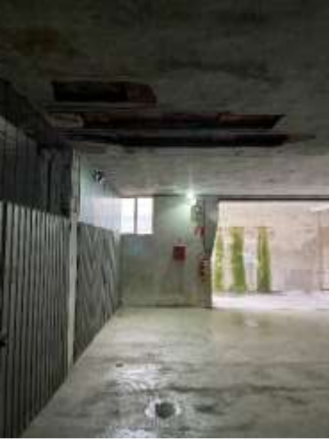
Piano interrato area comune
