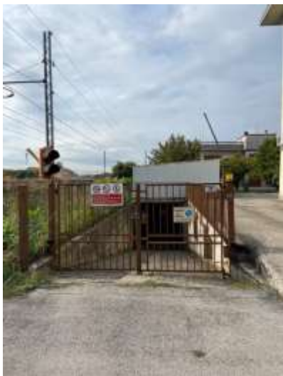
Esterno, accesso carraio
