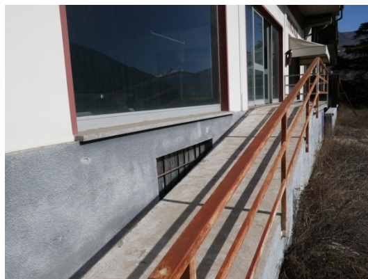
ACCESSO CON RAMPA
