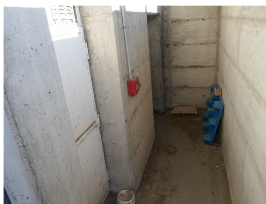
ACCESSO DA RAMPA ESTERNA
