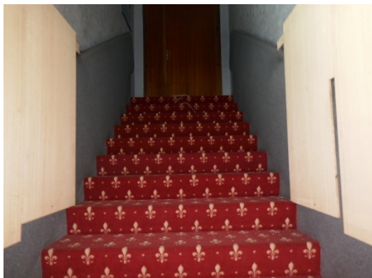
SCALA DI ACCESSO
