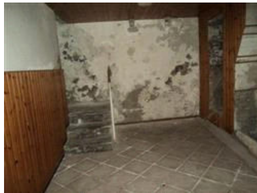
Interno edificio cucina P1
