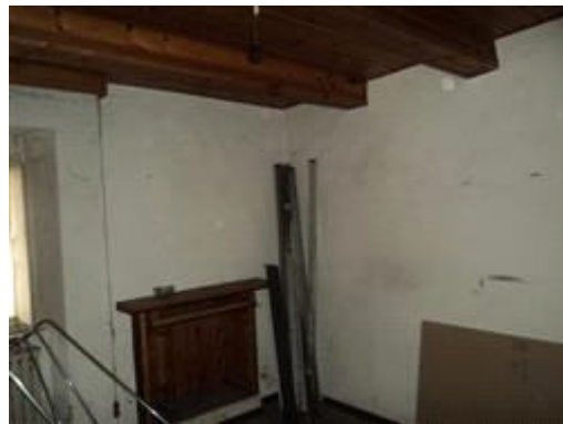
Interno fabbricato PT
