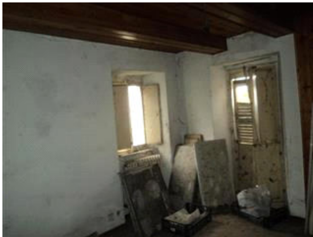
Interno fabbricato PT
