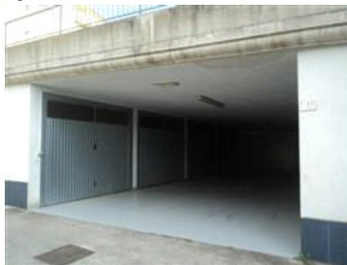
Ingresso ai garage con civico n. 17
