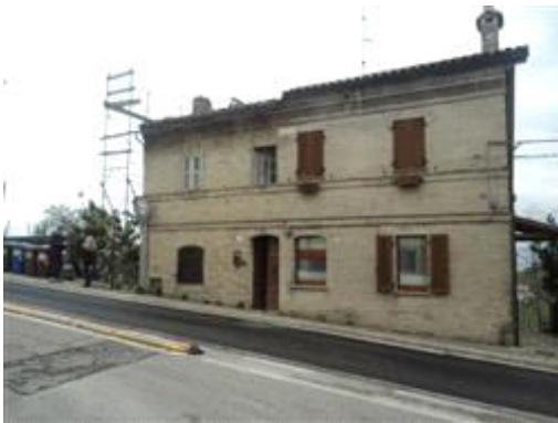
Esterno fabbricato su via Armando Diaz
