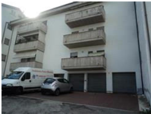
Porzione di edificio palazzina D su via Andrea da Bologna
