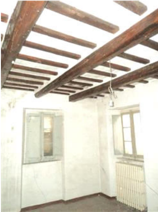
Interno fabbricato camera P1
