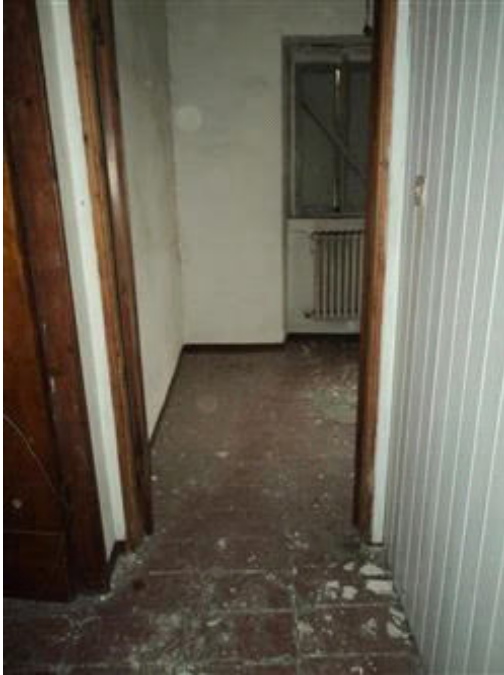
Interno edificio disimpegno P1
