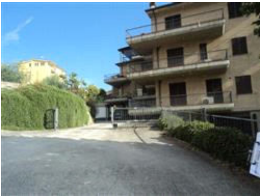
Rampa di accesso da via Mario Agnozzi
