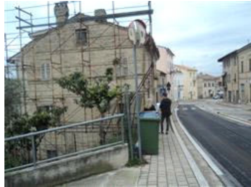
Esterno dell'edificio prospetto est visibile da via Armando Diaz
