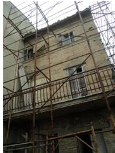
Esterno edificio prospetto sud PS1-T-1-2 con balcone
