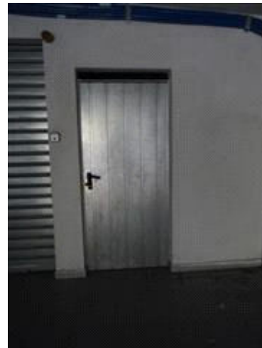
Porta di ingresso alla cantina sub 5
