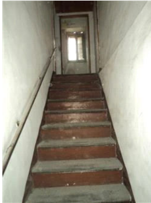
Interno fabbricato scala di collegamento
