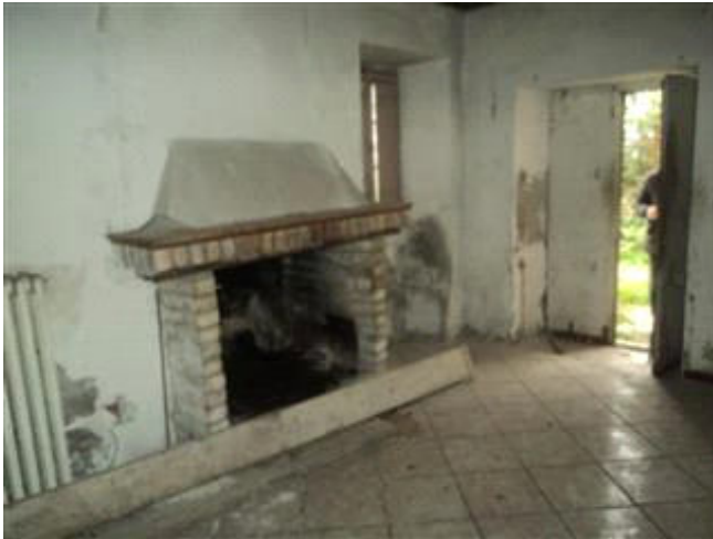
Interno edificio cucina PS1
