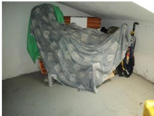
Interno soffitta P4 sub 26
