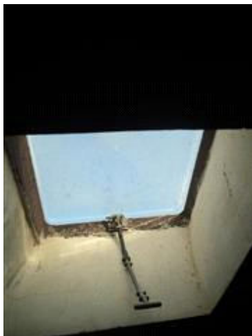
Interno soffitta P4 sub 26, particolare lucernario
