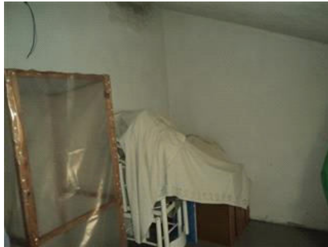
Interno soffitta P4 sub 26
