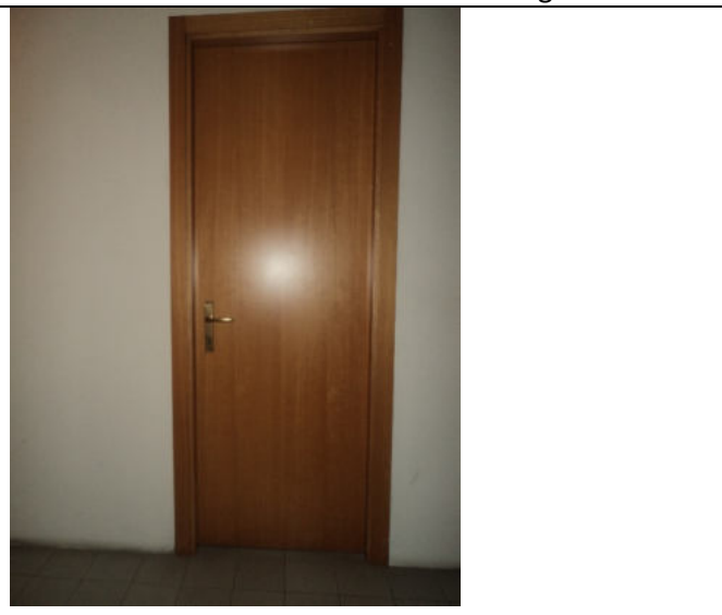
LOTTO 3 corpo A soffitta
