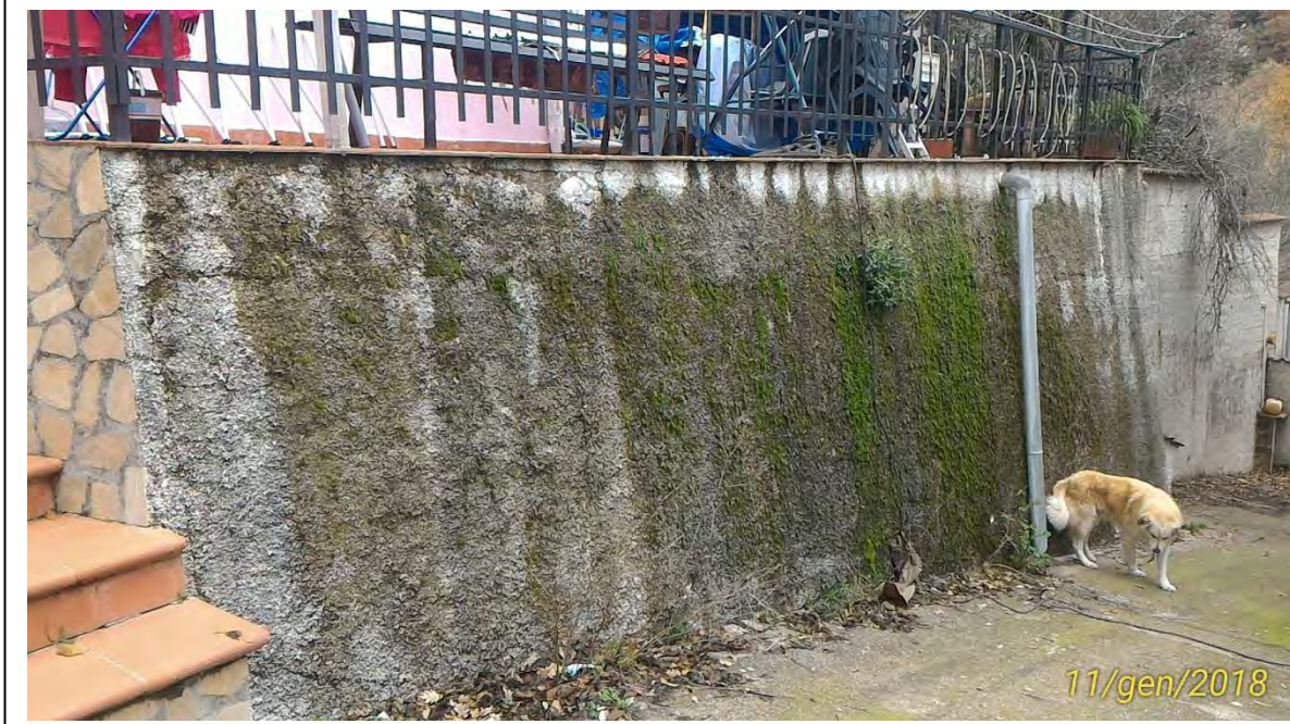
Fig. 12 – Visione particolareggiata opere di livellamento
