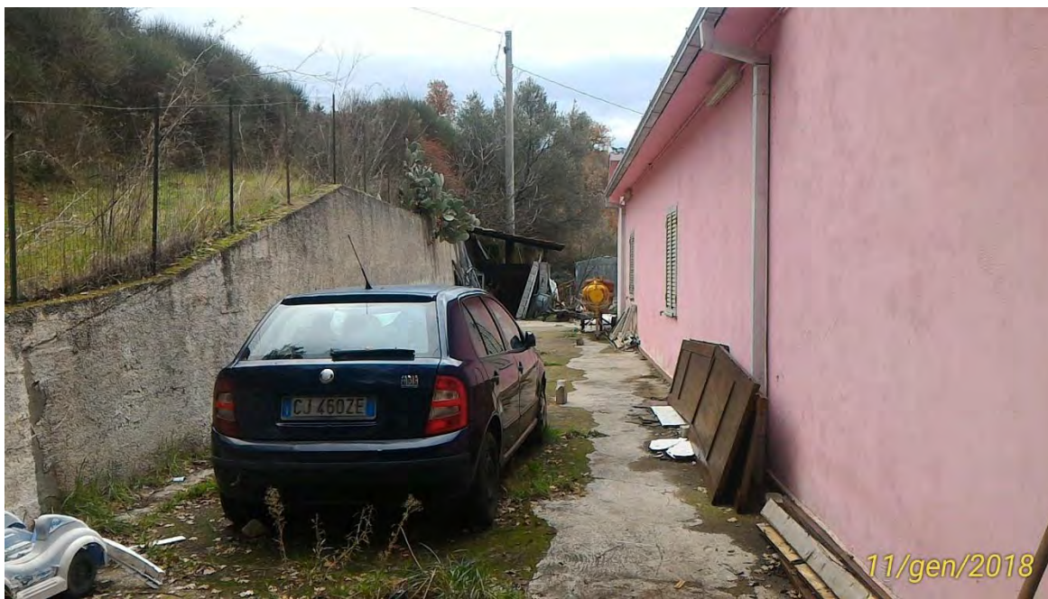
Fig. 2 – Visione particolareggiata del muro di sostegno
