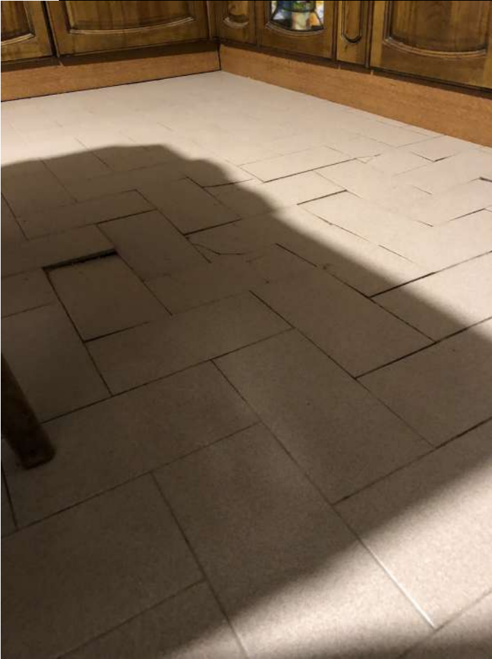
Foto 17- Piano 1 – cucina (dettaglio solaio e pavimento)
