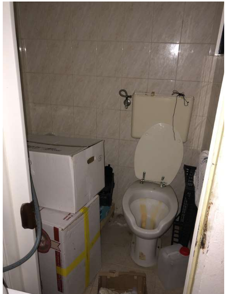
Foto 10- Piano terra – Cantina lato nord (WC)
