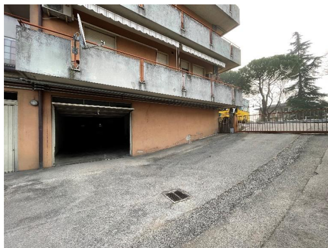
Vista del fabbricato da Ovest sull'accesso carraio
