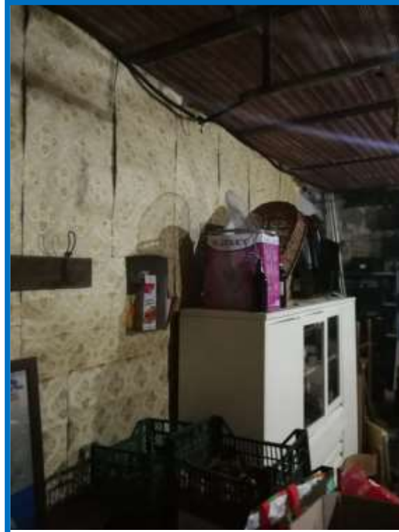
Foto n° 14 – Magazzino Piano Terra
