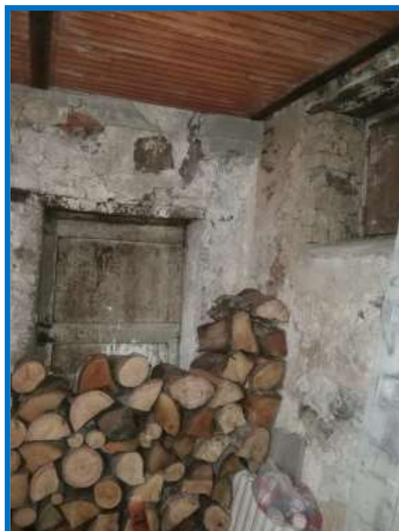
Foto n° 14 – Magazzino Piano Terra
