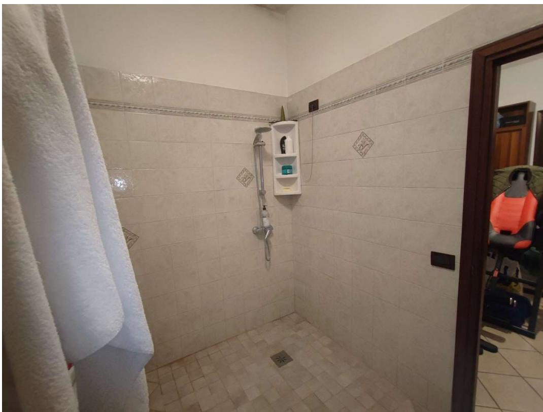
FOTO 19: vista interna (bagno n. 2)
