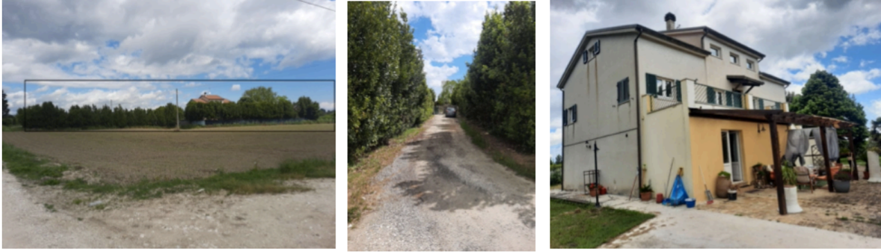
Figura 1 Fotografie area esterna - facciata immobile
