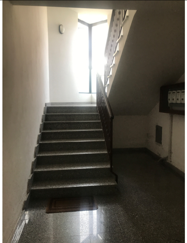
Vano scala condominiale
