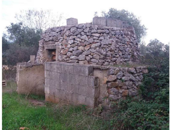
Figura 13 - Ripresa 10: scorcio trullo fronte Sud - Ingresso
