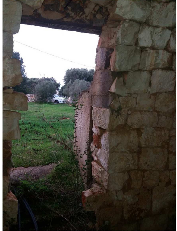
Figura 21 - Ripresa 20: ingresso principale
