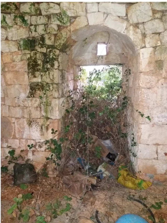
Figura 20 - Ripresa 17: ingresso secondario/vano principale
