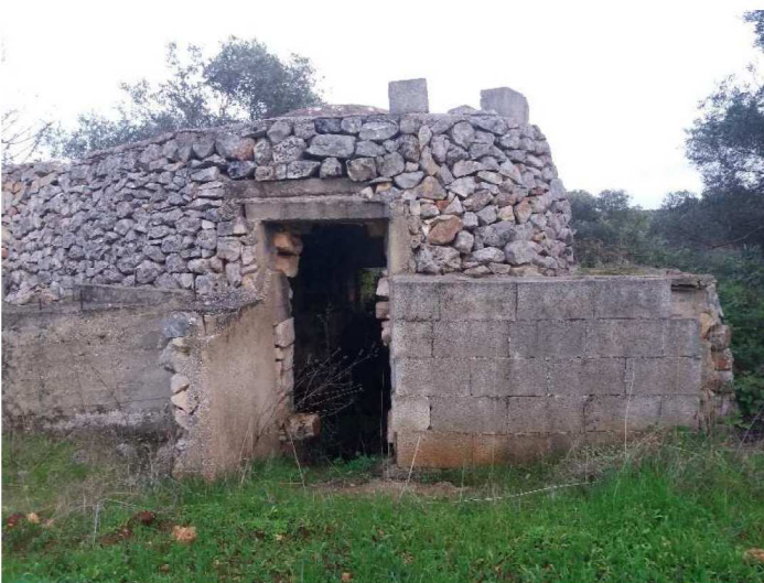
Figura 16 - Ripresa 13: Ingresso principale
