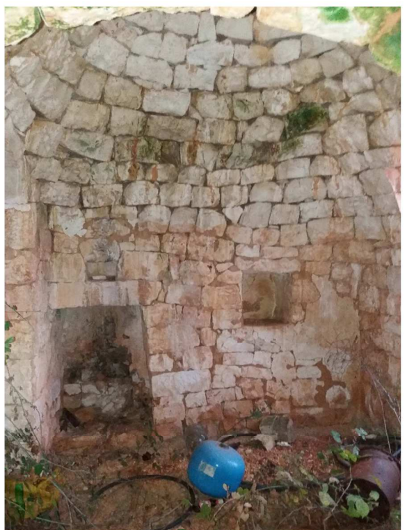
Figura 21 - Ripresa 18: vano principale
