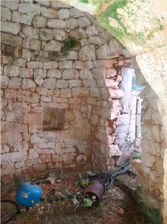
Figura 22 - Ripresa 19: vano principale
