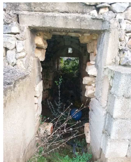
Figura 17 - Ripresa 14: Ingresso principale
