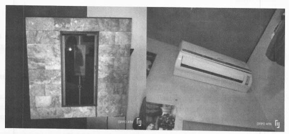
Anche per l'impianto di climatizzazione si può asserire che, nel complesso, il sistema risulta in linea con i più comuni impianti di installazione, ma fino ad una nuova completa revisione, con emissione di dichiarazione / certificazione di conformità da ditta abilitata, ed è quindi da ritenersi non conforme alla normativa vigente.
