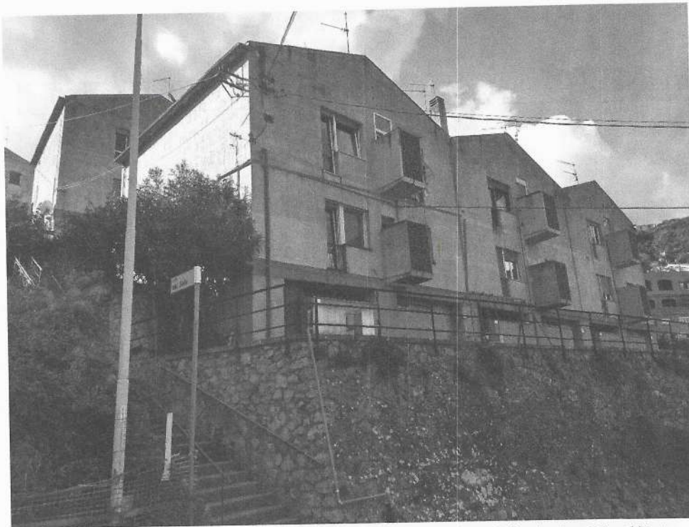
Foto N°1. Vista del fabbricato da Via Del Sole – Facciata Principale a Nord/Est e Facciata/fianco laterale a Est.
