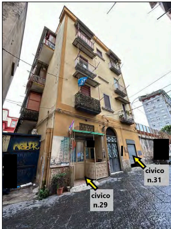
Foto 14. Il civico 31 di accesso al piano terra del sub. 25 e il civico 29 di accesso al piano S1, sotto strada, del sub. 25
