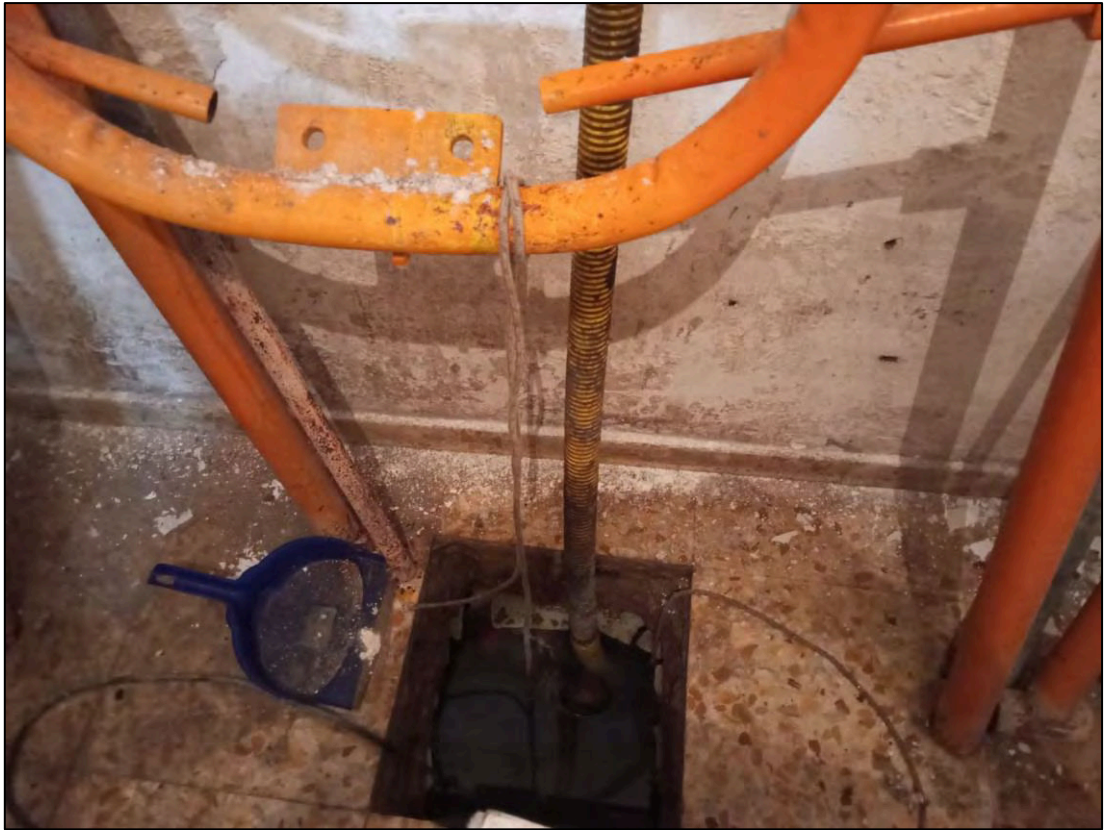
Foto 21. Stanza n. 7. Particolare del pozzo nella pavimentazione con la pompa di sollevamento
