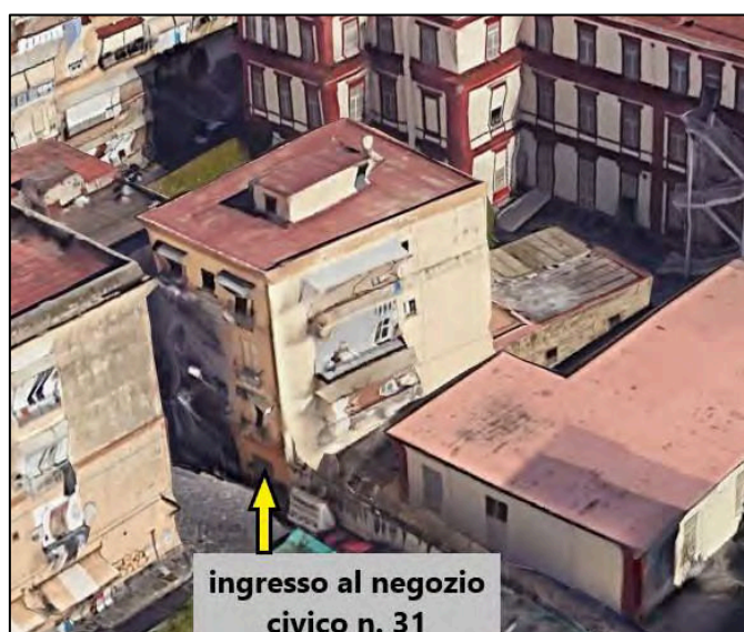
Foto 2. Il fabbricato di via S.M. delle Grazie a Loreto 30 con l'individuazione dell'ingresso al sub. 25 dal civico n. 31 di via S.M. delle Grazie a Loreto
