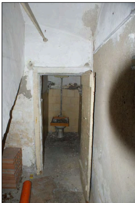
Foto 8. Disimpegno sul fondo l'ingresso al wc.
