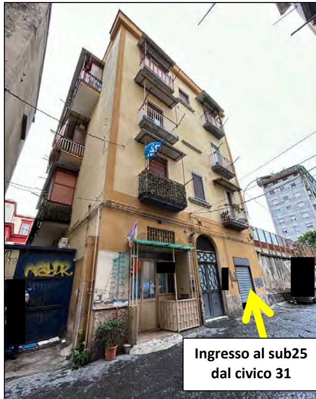
Foto 3. Accesso al piano terra del sub. 25 dal civico n. 31 di via S.M. delle Grazie a Loreto.
