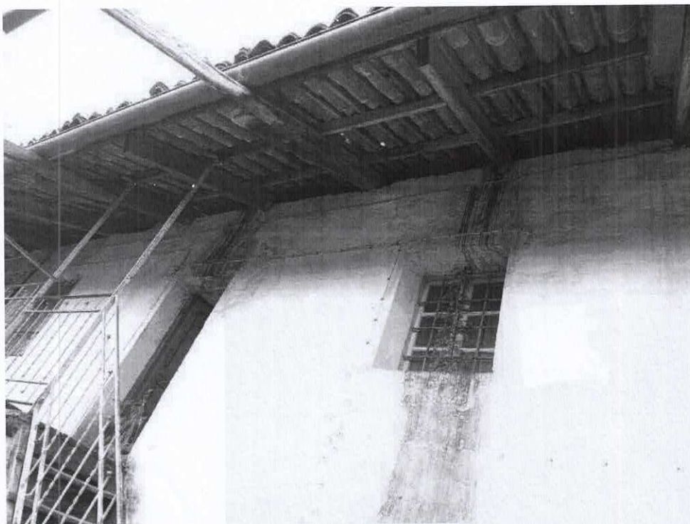
Foto n°23: colature d'acqua proveniente dal tetto e muffe sulla facciata
