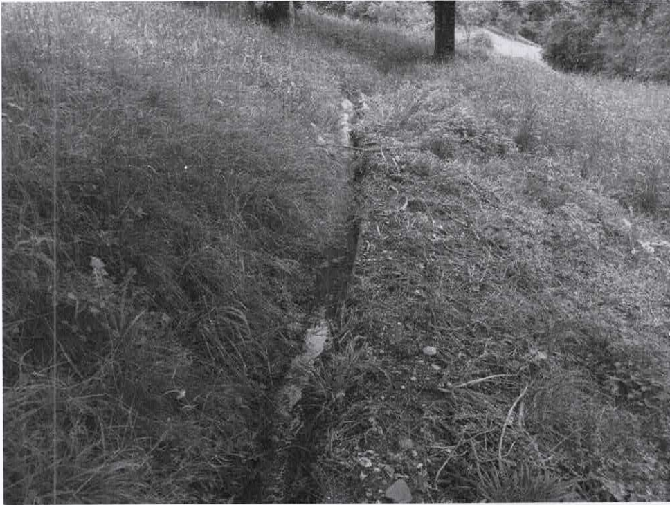
Foto n°17: cunetta in terra percorsa dai reflui fognari
