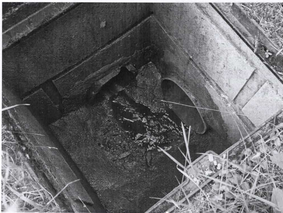
Foto n°9: primo pozzetto fognario sulla proprietà
