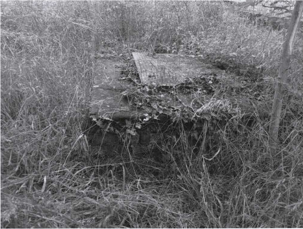
Foto n°13: erosione del terreno intorno al pozzetto Ovest
