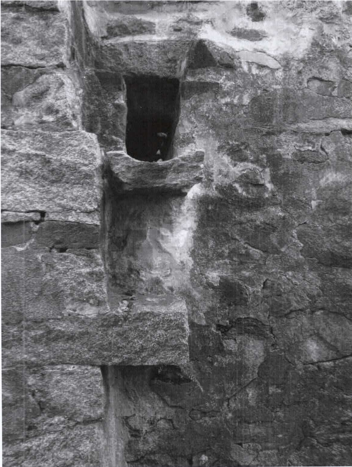
Foto n°11: particolare doccione di scarico sul vicolo
