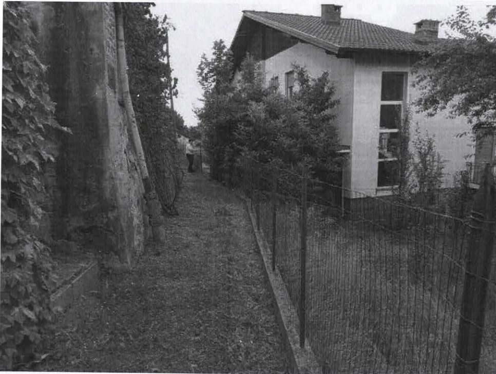
Foto n°4: il vicolo percorso dalla condotta fognaria
