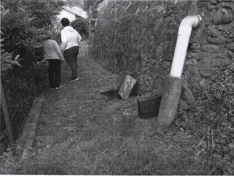
Foto n°5: vicolo con pozzetto fognario
