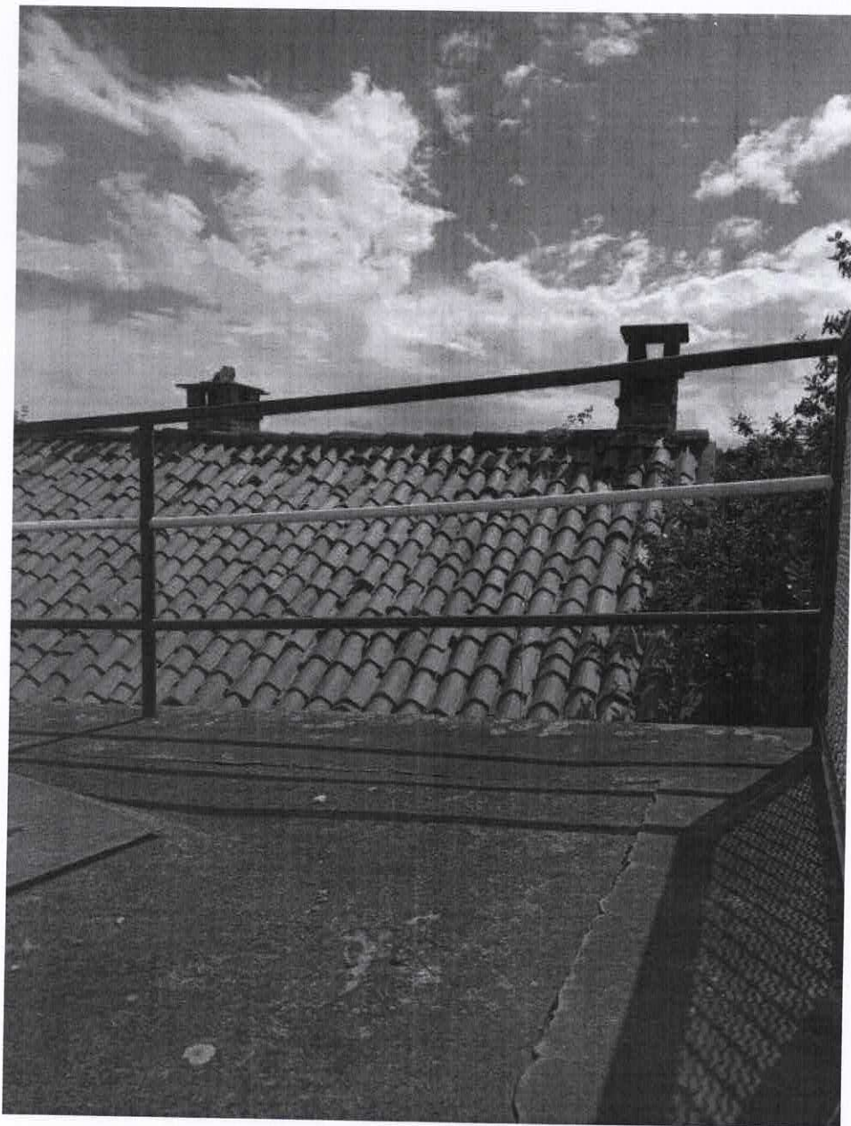
Foto n°31: manto di copertura, con coppi rotti, scivolati e rimaneggiati
