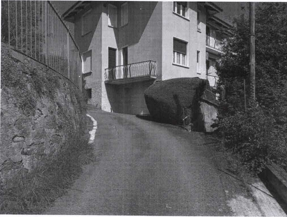
Foto 3: edificio particella n°370, diritto di passaggio sulla strada di accesso pr. f
