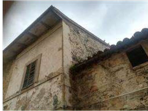
porzione piano primo e secondo
