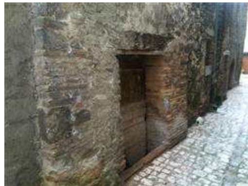
particolare ingresso a piano seminterrato
