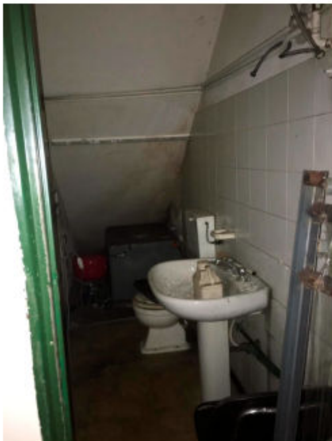
FOTO N. 29 BAGNO SOTTOSCALA IN VIA BENEDETTO SCILLAMA' N. 58
