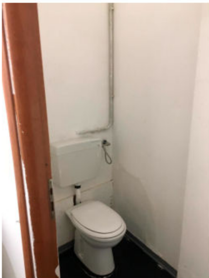
FOTO N. 31 WC IN VIA BENEDETTO SCILLAMA' N. 56
