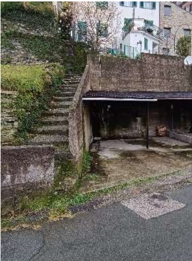
Foto 5 - Inizio sentiero pedonale.
