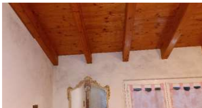
Foto 27 - Soffitto camera nord-est.
