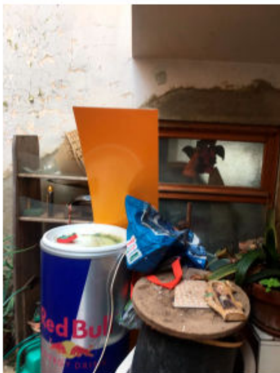
FOTO N. 69 FINESTRA LATO PATIO SOTTO SCALA
