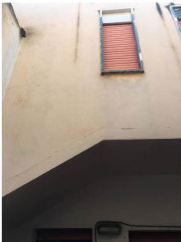
FOTO N. 81 VISTA FINESTRA FINE SCALA LIVELLO SECONDO PIANO
