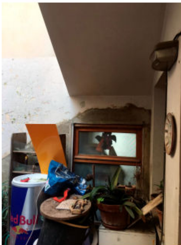
FOTO N. 67 FINESTRA LATO PATIO SOTTO SCALA
