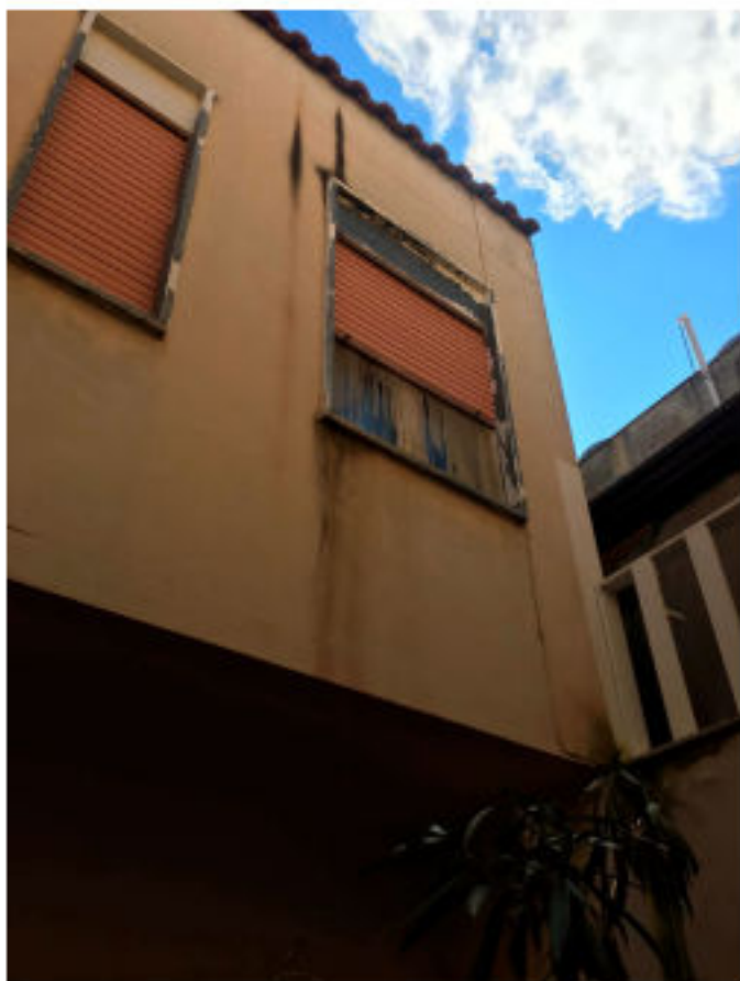
FOTO N. 83 VISTA FINESTRA FINE SCALA E CAMERA DA LETTO LIVELLO SECONDO PIANO
