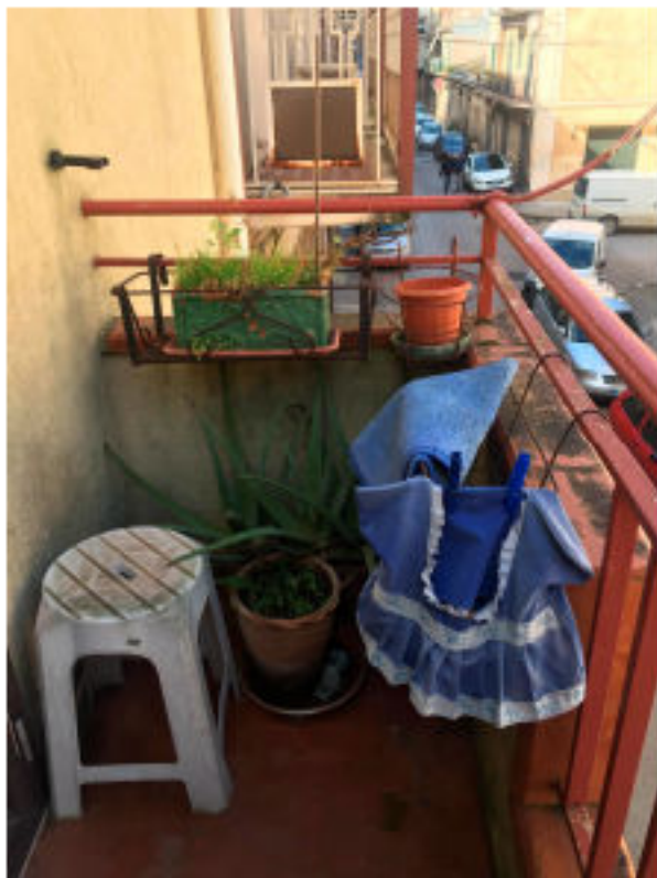
FOTO N. 51 BALCONE VIA BENEDETTO SCILLAMA'
