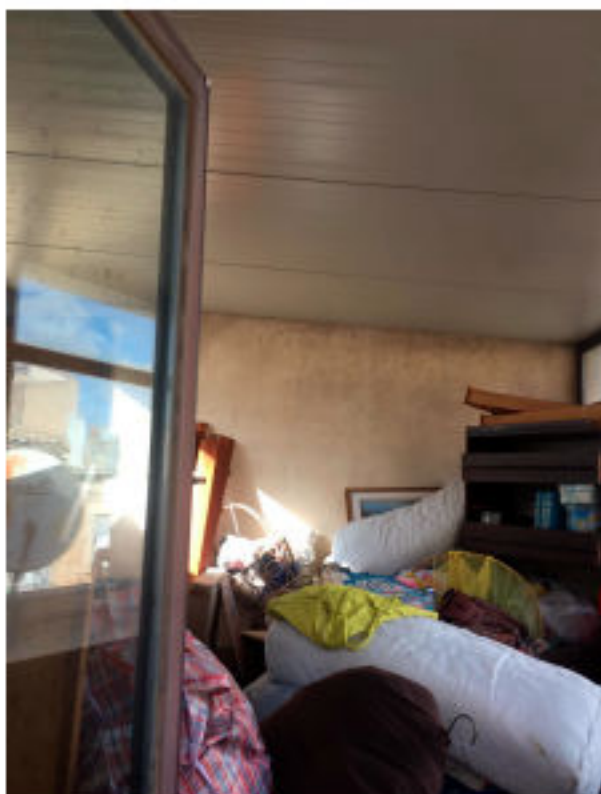
FOTO N. 118 VISTA INTERNA DEPOSITO TERRAZZA
