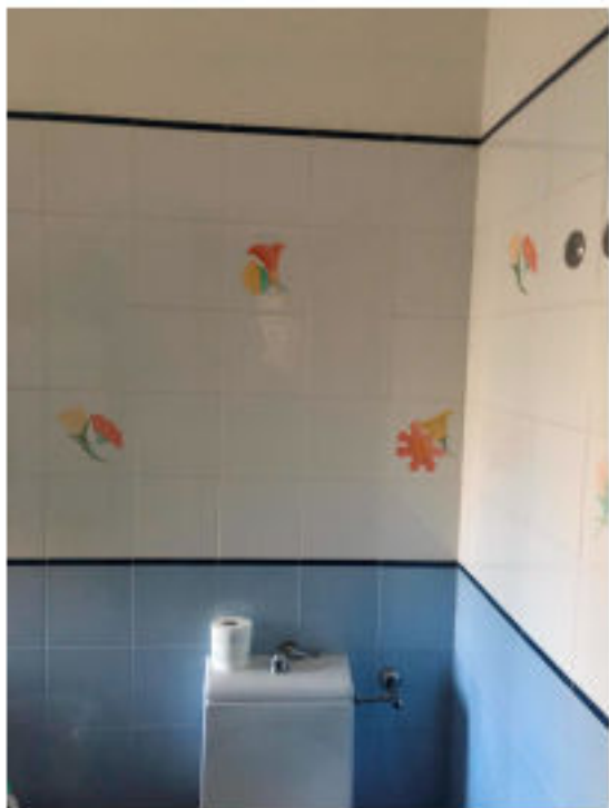
FOTO N. 111 BAGNO SECONDO PIANO
