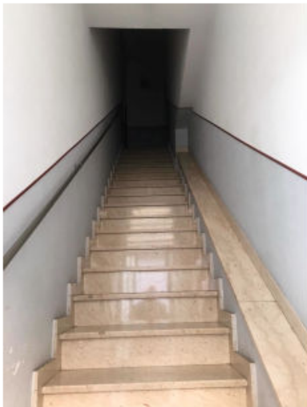
FOTO N. 35 SCALA DI INGRESSO IMMOBILE PRIMO PIANO IN VIA BENEDETTO SCILLAMA' N. 60
