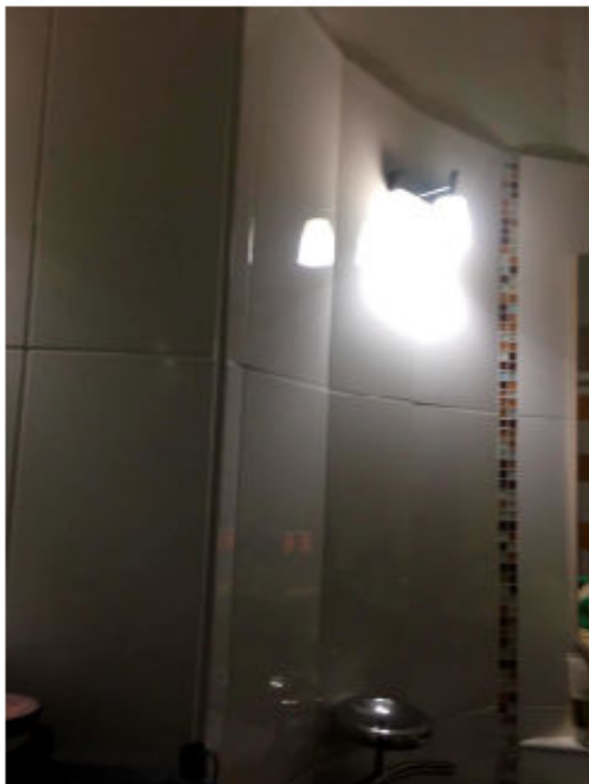
FOTO N. 89 BAGNO AL PRIMO PIANO
