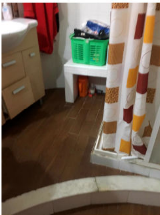
FOTO N. 88 BAGNO AL PRIMO PIANO
