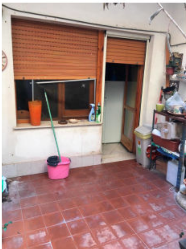
FOTO N. 66 VISTA ESTERNA BALCONE LATO PATIO
