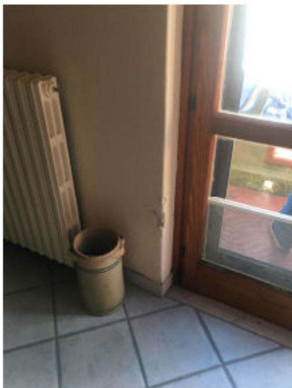
FOTO N. 48 MANUTENZIONE PARETE SOGGIORNO BALCONE SU VIA BENEDETTO SCILLAMA'
