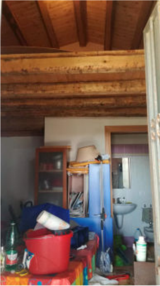
FOTO N. 15 VISTA INTERNA FABBRICATO RURALE
