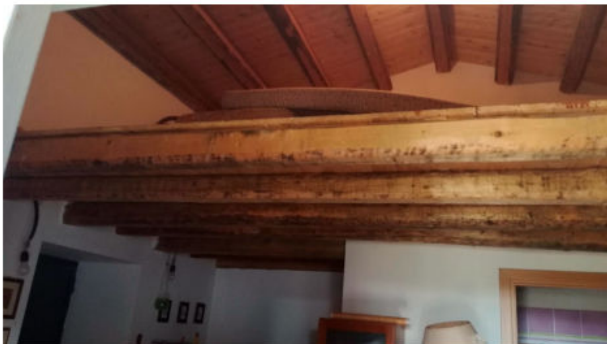
FOTO N. 13 VISTA INTERNA FABBRICATO RURALE SOPPALCO TETTO IN LEGNO
