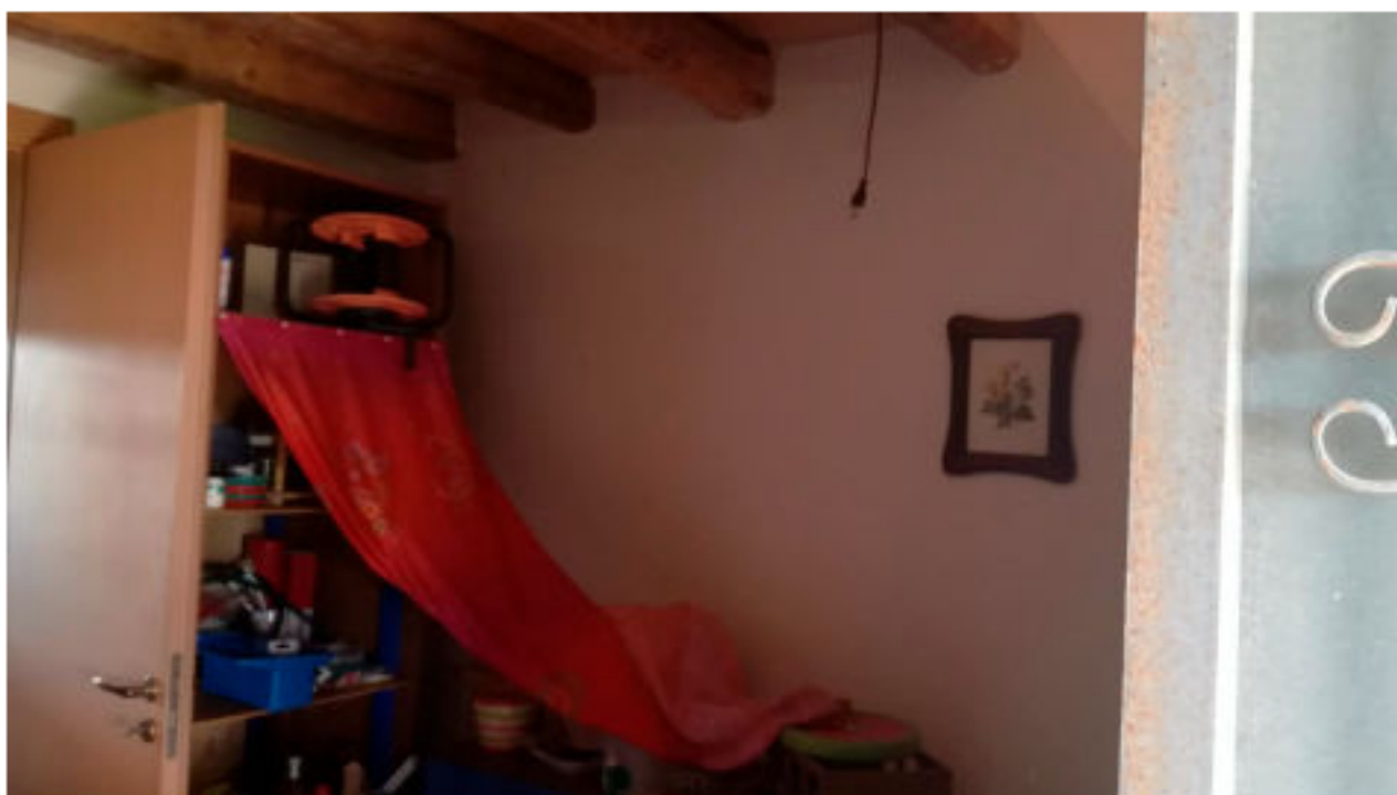
FOTO N. 14 VISTA INTERNA FABBRICATO RURALE
