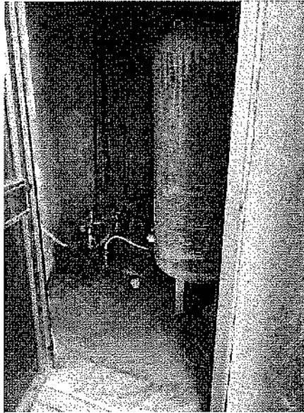
Foto n. n 15 bene n. 5 Deposito sito in Reggio Calabria alla Via Gebbione n. 3 - In Catasto al NCEU F 128/RC part. 118 sub 11
