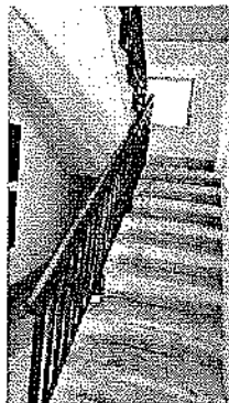
Foto . 10 vano scala
