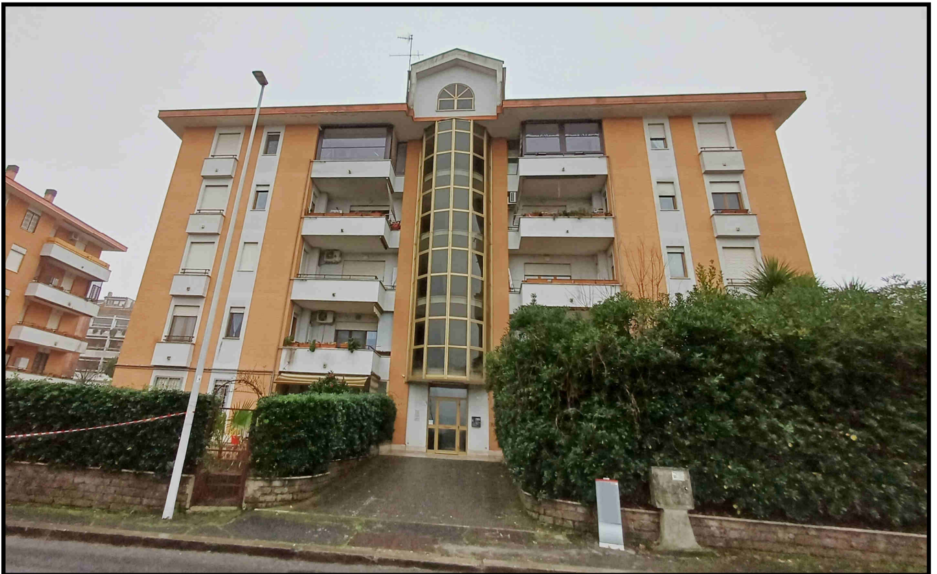
Foto 2: La facciata principale con il portone di accesso al fabbricato.
