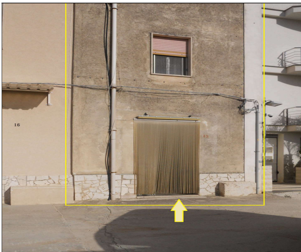
Foto 9: Panoramica esterna - Fabbricato p. T-1 C.da Fricia n. 15 - Alcamo.
