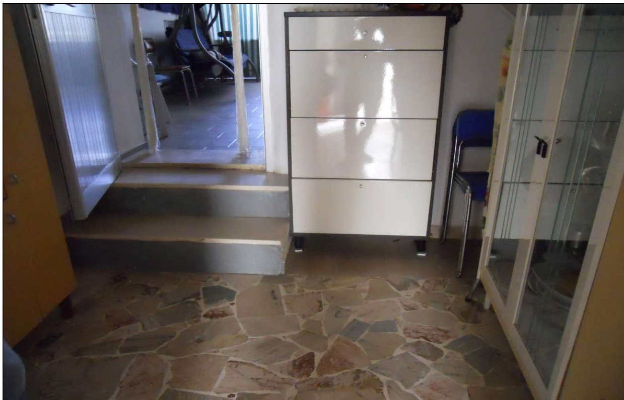
Foto 11: vano disimpegno centrale piano terra – C.da Fricia n. 15 - Alcamo.
