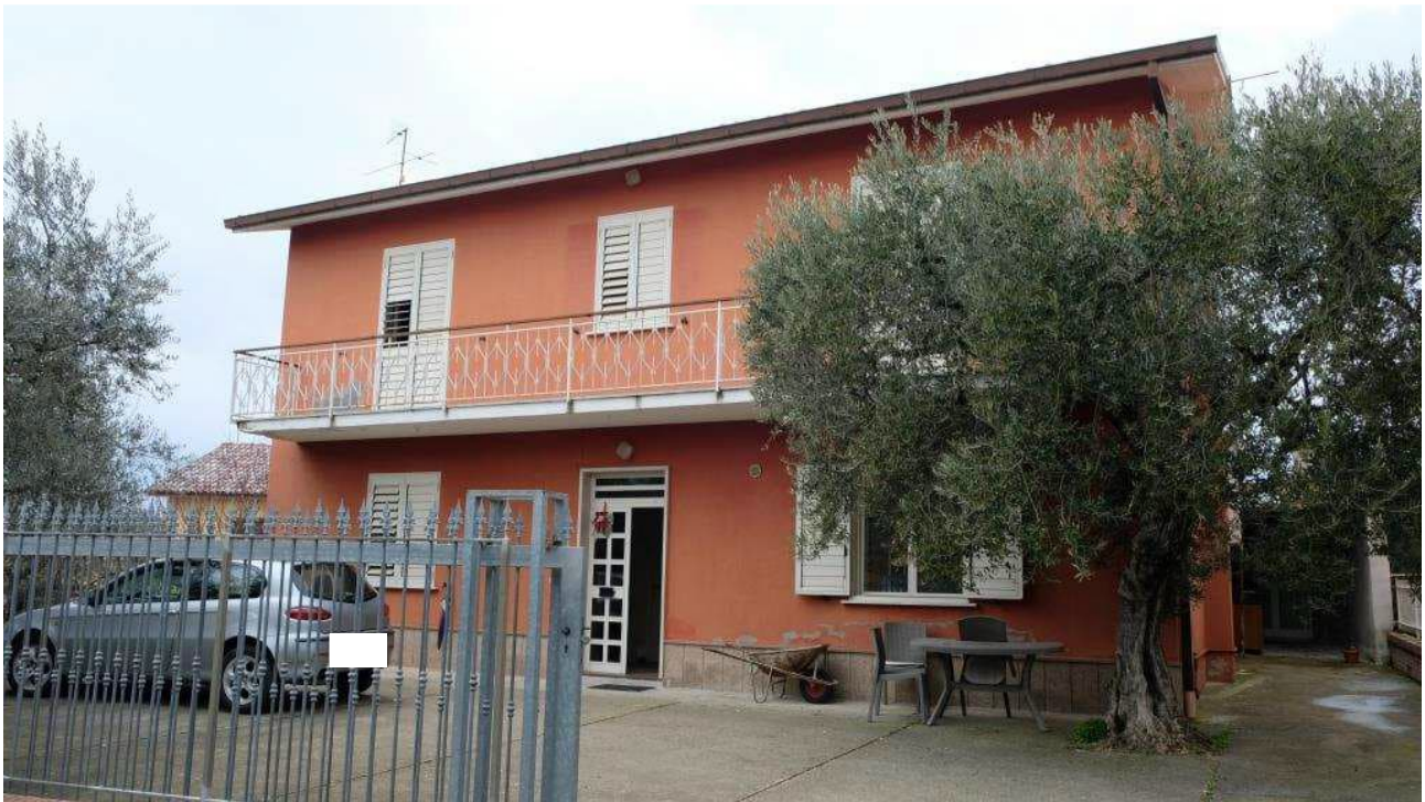
Foto 1 – Vista dell’abitazione dalla pubblica strada
