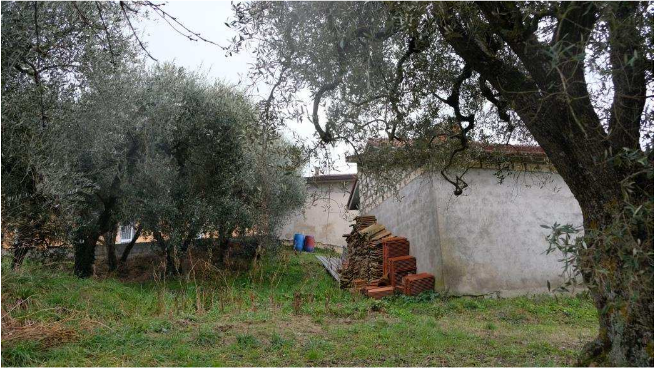
Foto 17 – Vista dell’autorimessa lato NORD
