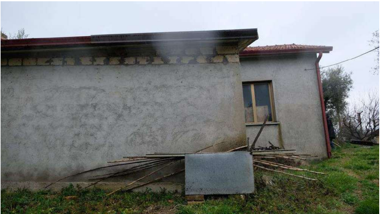
Foto 16 – Vista dell'autorimessa lato OVEST
