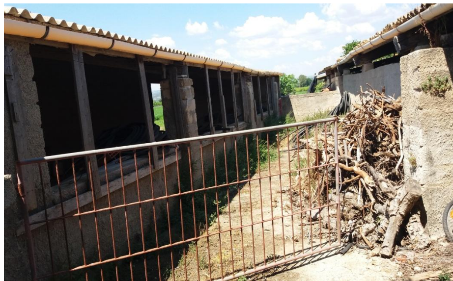
Foto 2 – Fabbricato rurale (cortile)
