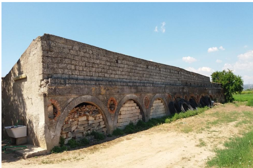
Foto 1 – Fabbricato rurale: C.da Laganelli , Fig. 110 - p.la 451 - Siracusa
