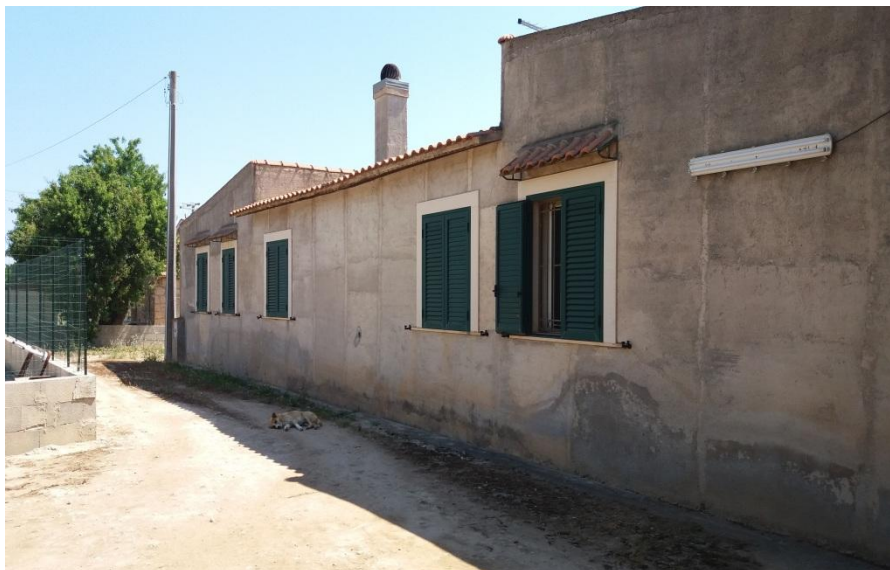
Foto 3 – Fabbricato rurale (versante Ovest)
