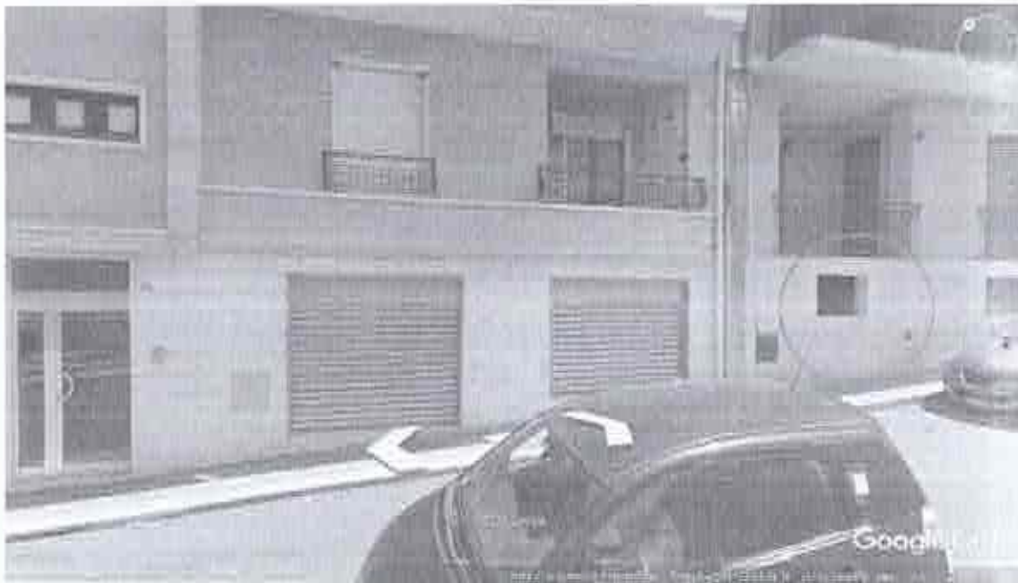
Situazione ad oggi
