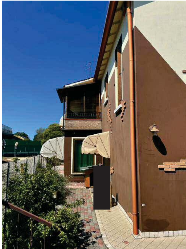
Dettaglio prospetti Sud e Est dell'edificio (abitazione in porzione di edificio bifamiliare)
