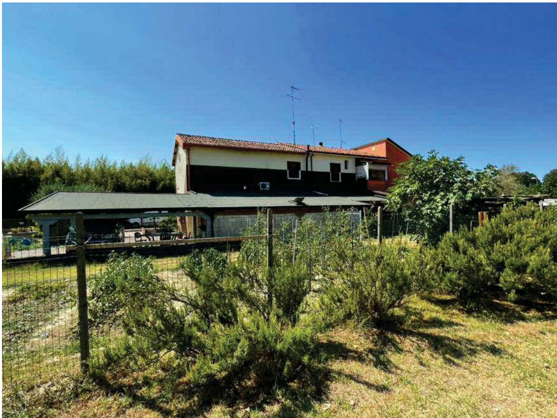
Prospetto Nord dell'edificio (abitazione in porzione di edificio bifamiliare)
