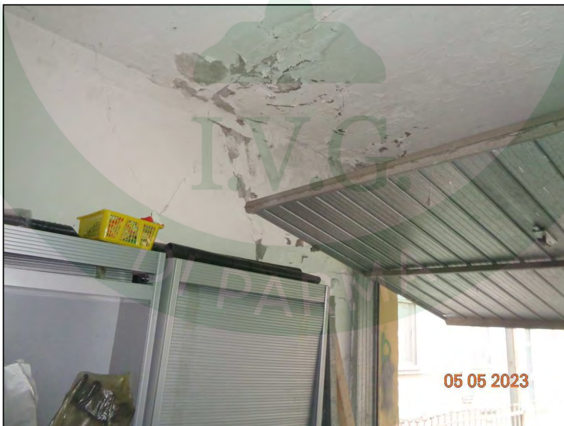
Foto 34 - Autorimessa piano terra
