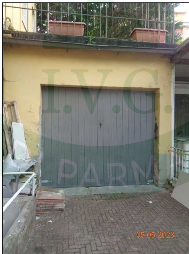
Foto 32 - Autorimessa piano terra
