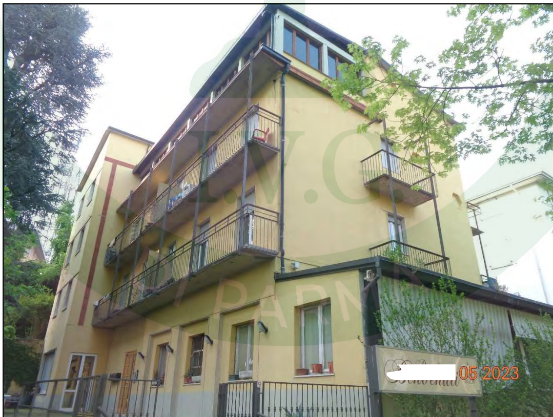
Foto 2 – Vista fronte strada
