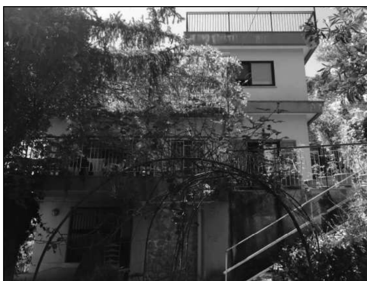
Foto 8 prospetto lato Nord
