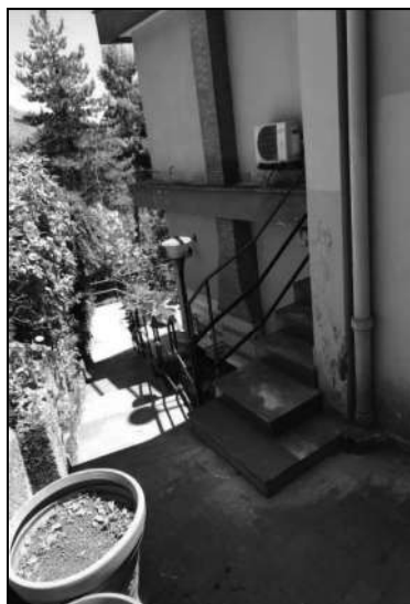
Foto 5 scala di collegamento
