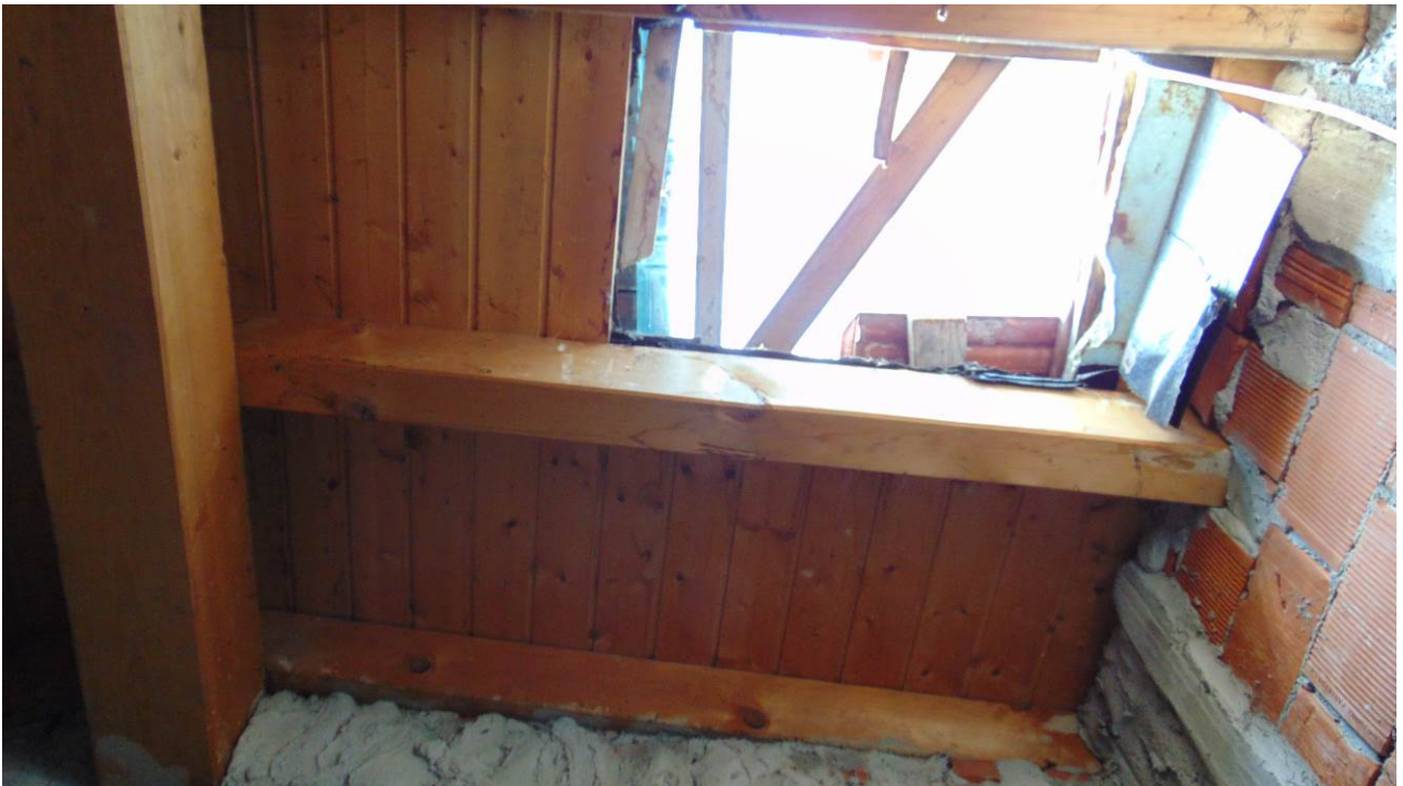
Foto 37 _Dettaglio lucernario nel ripostiglio
