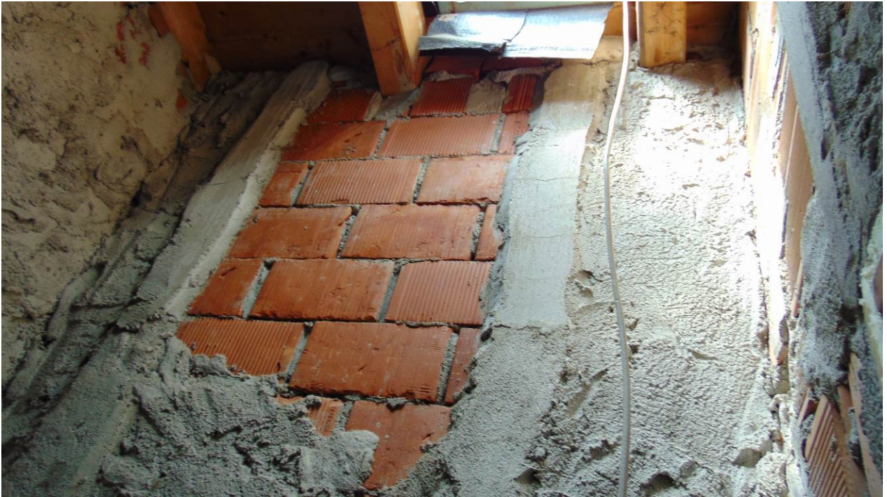
Foto 36 _Stato di fatto ripostiglio in zona notte piano secondo
