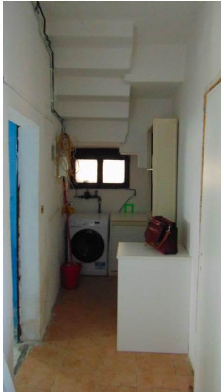
Foto 22_Dettaglio vano lavanderia ricavato nel sottoscala che divide il magazzino dall'ingresso al piano terra
