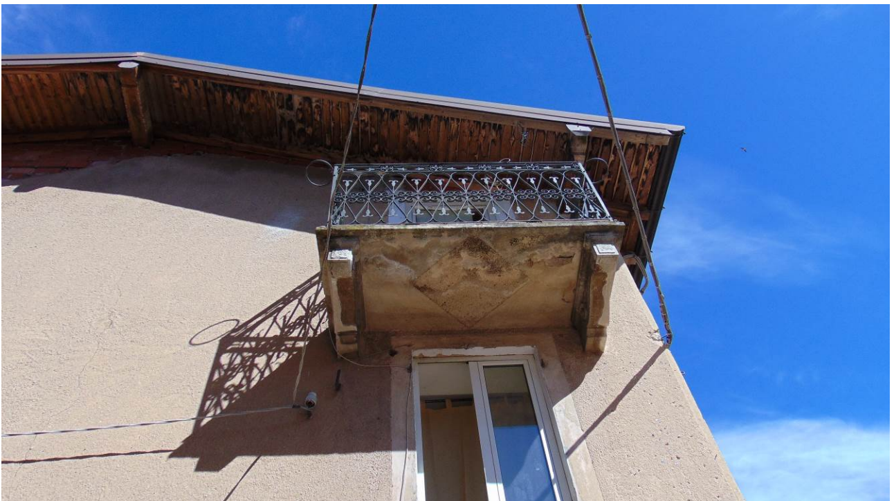
Foto 8_Balconcino al piano secondo zona notte
