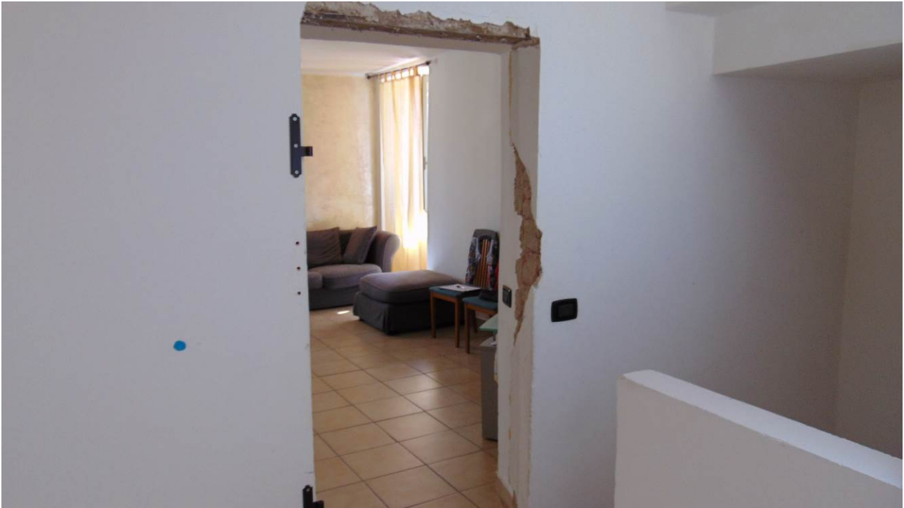
Foto 28_ Stato di fatto ingresso zona giorno al piano primo da vano scala
