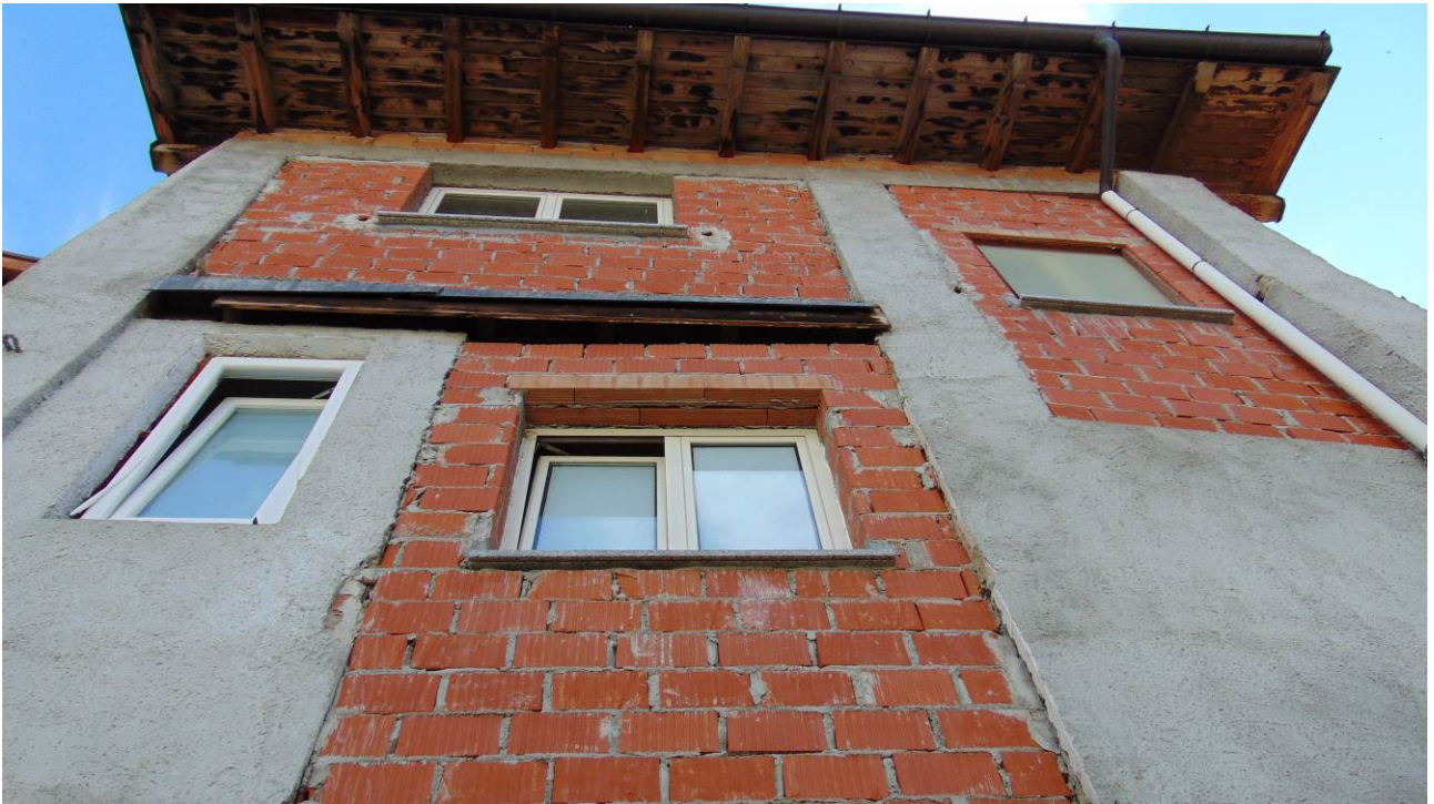
Foto 3_Prospetto sovrastante accesso principale abitazione su corte comune.
