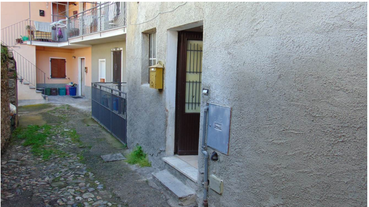
Foto 4_Ingresso principale con scalini non accessibile (BB.AA.)
