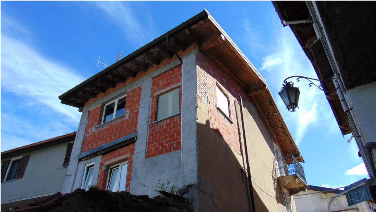
Foto 9_Dettaglio d'angolo ripreso da stradina laterale via Asmara e XXXXXX
