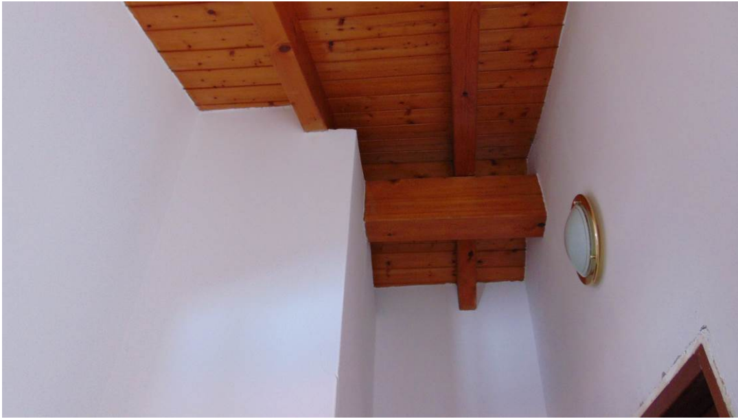
Foto 32_Dettaglio intradosso zona notte (tetto a vista)
