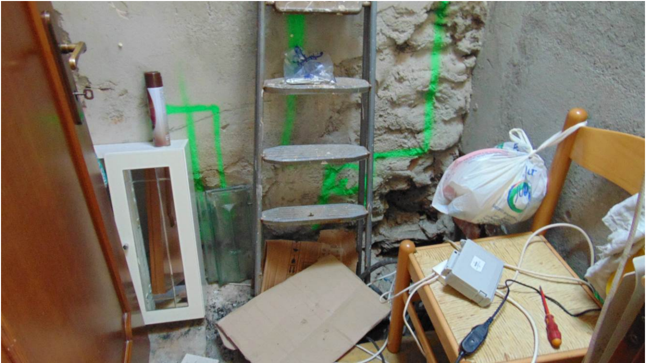
Foto 38_Dettaglio ripostiglio al piano secondo
