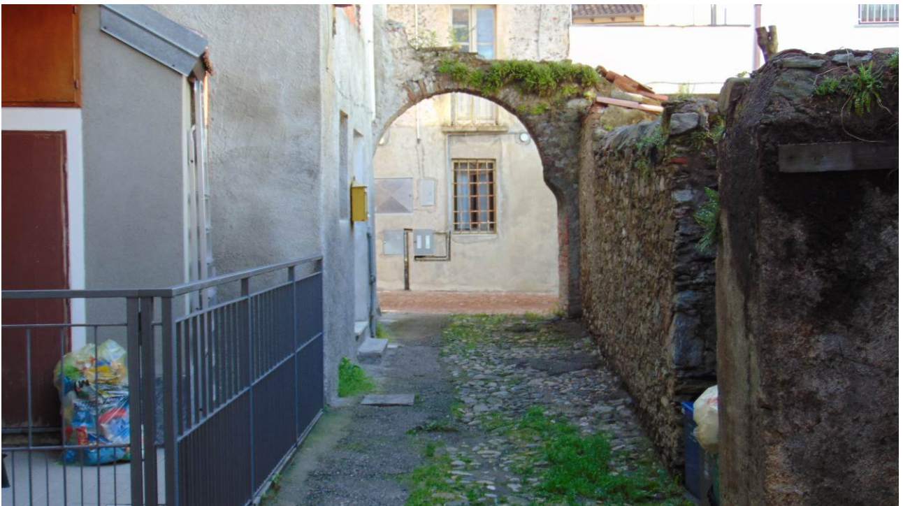
Foto 6_Accesso in corte comune
