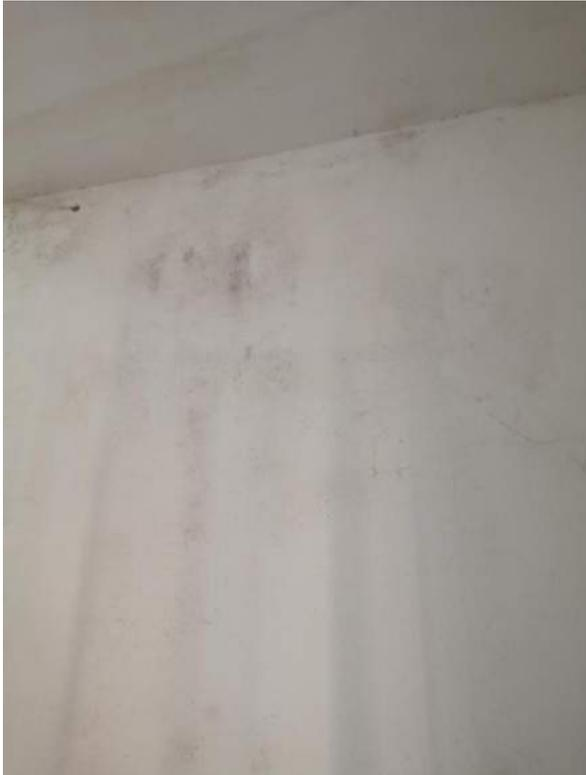
Foto 49 Particolare umidita murature e soffitto camera 1
