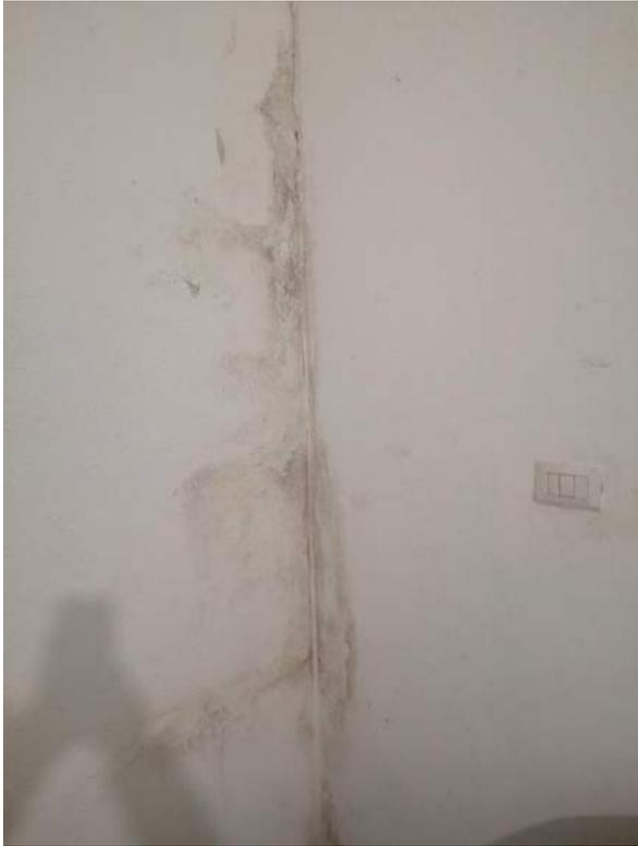
Foto 33 Particolare umidità murature e soffitto soggiorno
