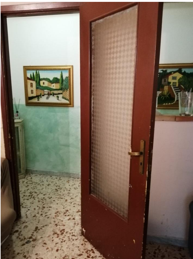
FO-L1-17 RIFINITURE IMMOBILE – INFISSI INTERNI E PAVIMENTAZIONE - CONDIZIONI
