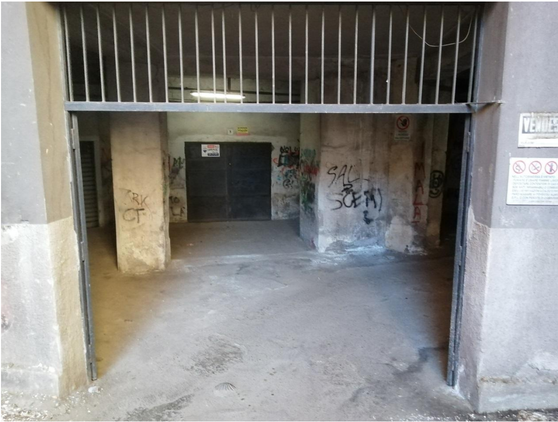
FO-L2-1 INGRESSO ALL'AREA COMUNE DI TRANSITO E MANOVRA GARAGE LOTTO 2
