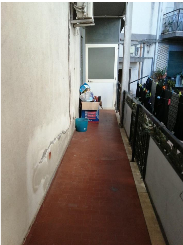
FO-L1-9BALCONE LATO CUCINA/SOGGIORNO CON VERANDA
