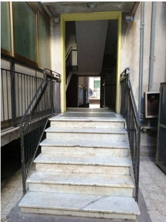
INGRESSO SCALA B DA CUI SI ACCEDE ALL'ANDRONE DOVE E' UBICATO IL CORPO DI SCALE C CHE OSPITA L'APPARTAMENTO LOTTO 1 OGGETTO DI STIMA
