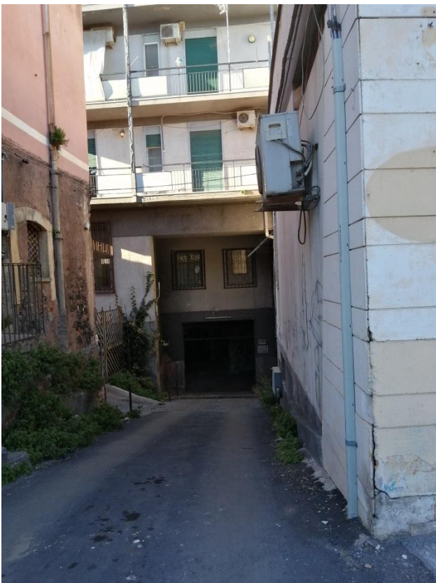
FO-L2- SCIVOLA DI INGRESSO AL LOCALE GARAGE LOTTO 2
