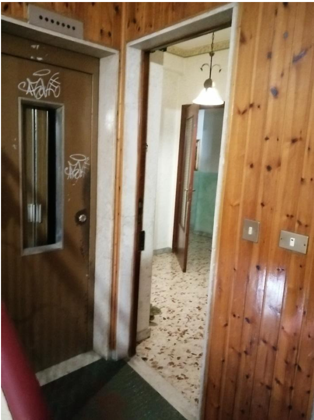
FO-L1-1 PORTA DI INGRESSO ALL'APPARTAMENTO INTERNO 1 CORPO DI SCALE C
