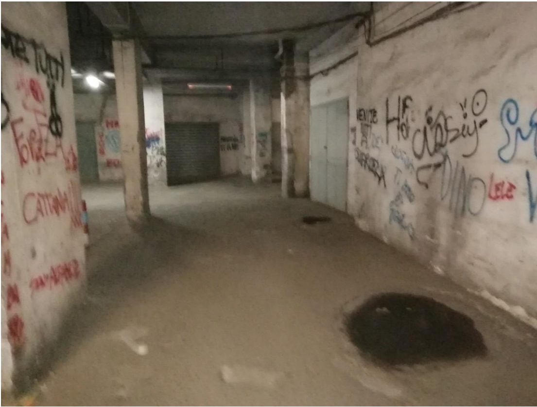
FO-L2-3AREA COMUNE DI TRANSITO E MANOVRA GARAGE LOTTO 2
