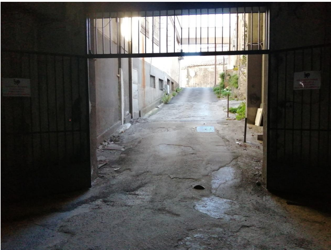
FO-L2-2 INGRESSO ALL'AREA COMUNE DI TRANSITO E MANOVRA GARAGE LOTTO 2
